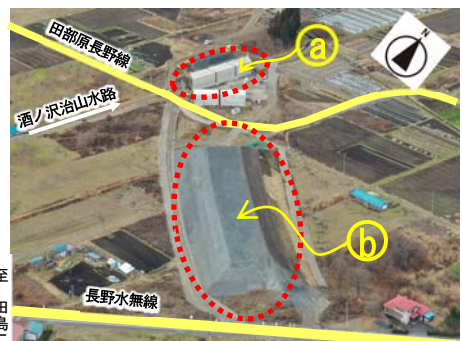
【写真3】工事状況写真(F21212撮影)
