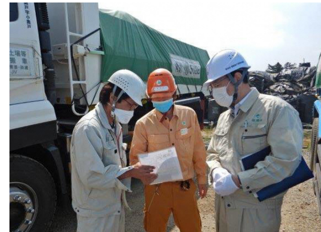
発注者安全点検の実施状況
