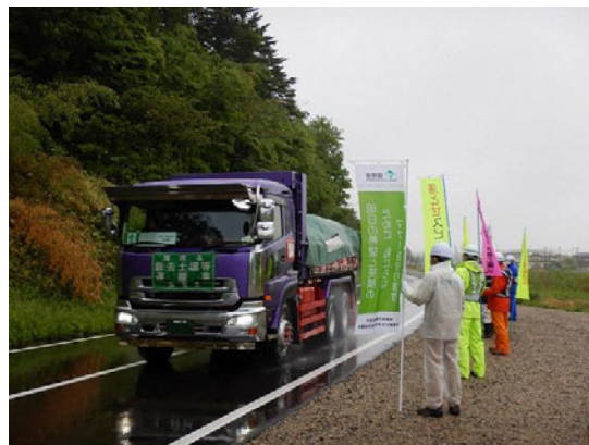
双葉町町道原田・目迫線確認
