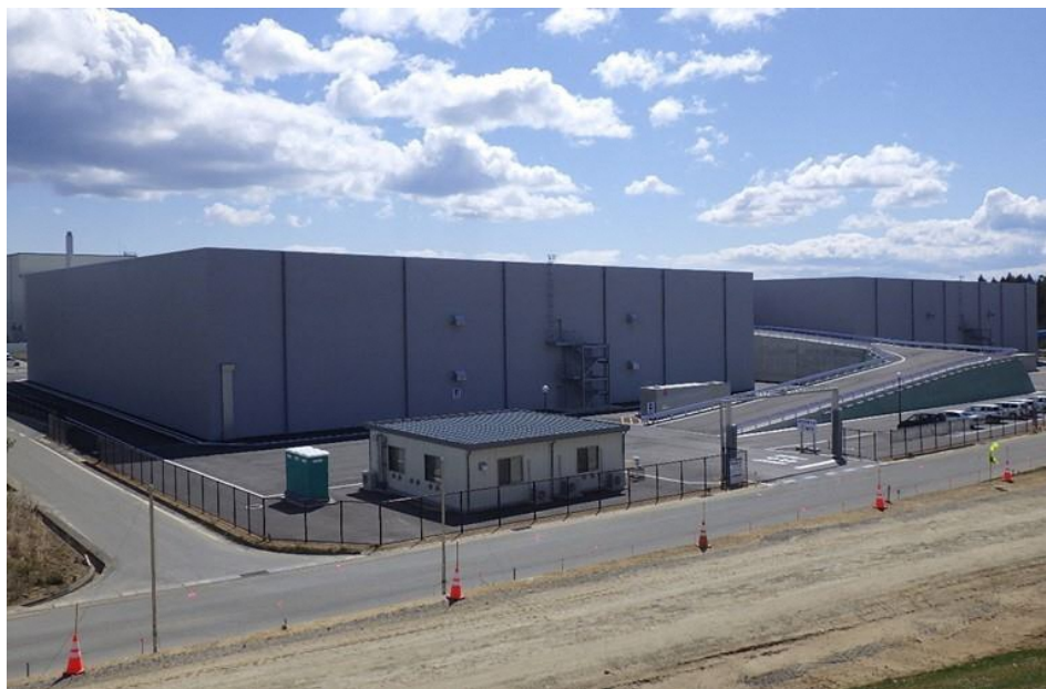
廃棄物貯蔵施設の外観
