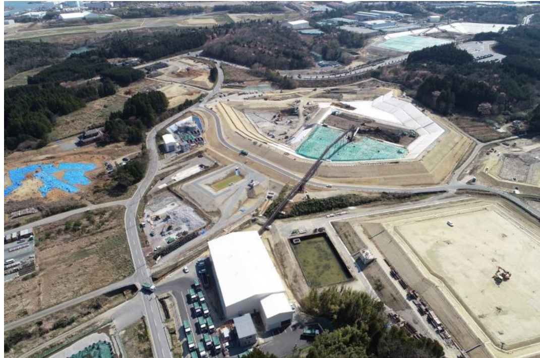
土壌貯蔵施設(西側)
