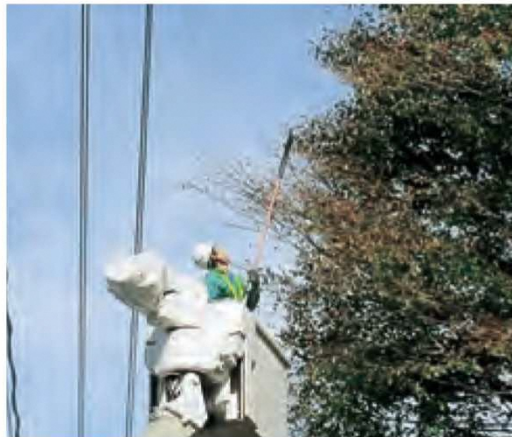
配電線保守作業などに伴う伐採
