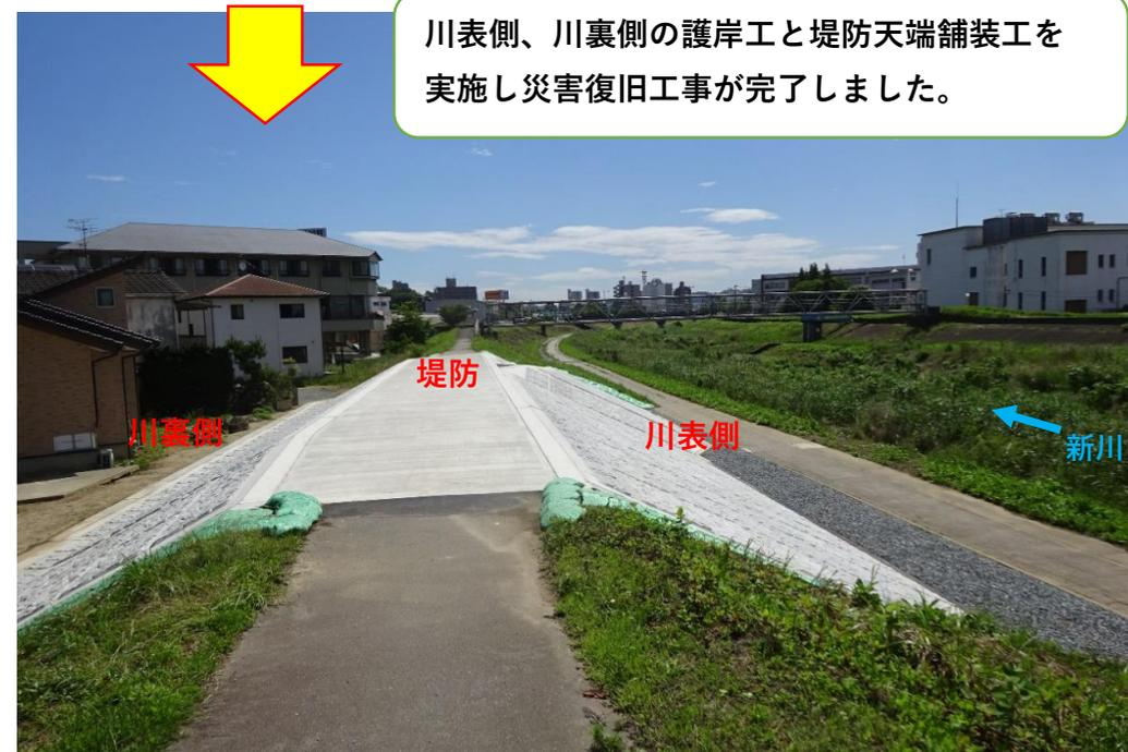
川表側、川裏側の護岸工と堤防天端舗装工を実施し災害復旧工事が完了しました。
