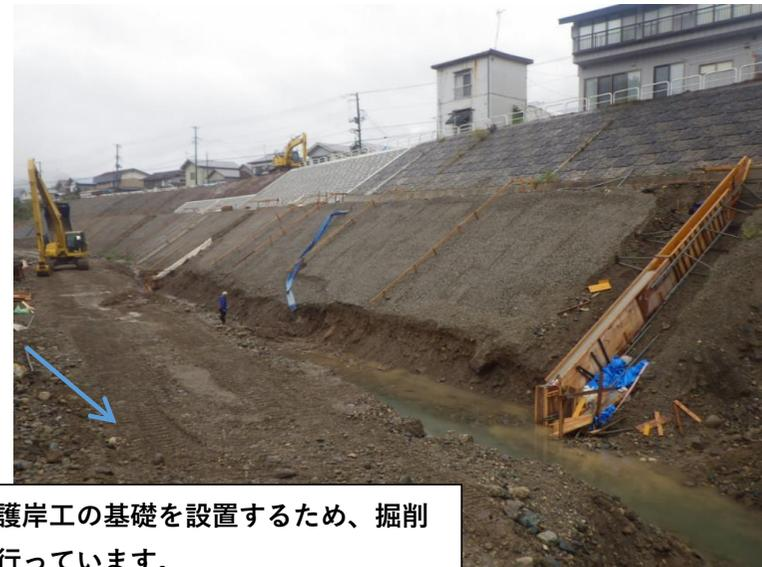
・護岸工の基礎を設置するため、掘削を行っています。
