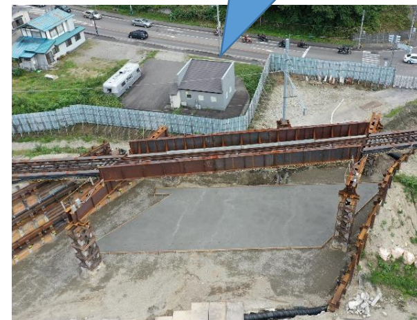
南会津町田島地内
