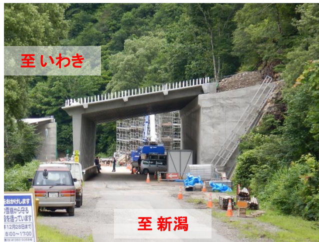
スノーシエツト工事状況
