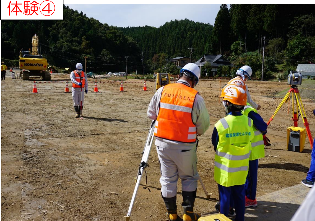
【ICT現場測量体験】 ◆自動追尾トータルステーションを体験しました。
