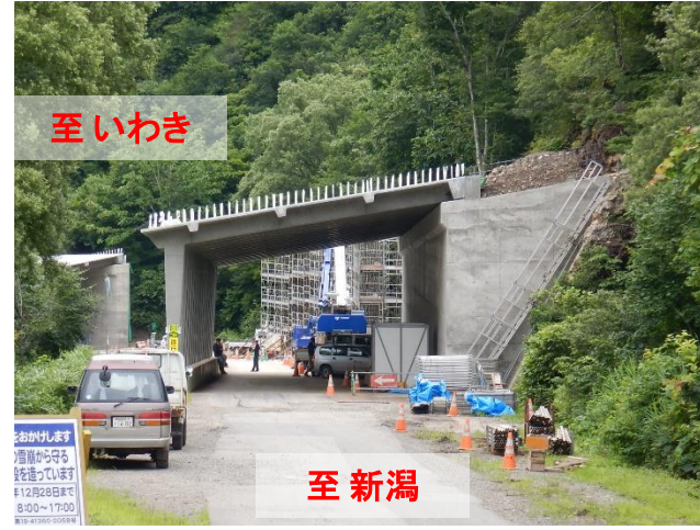
スノーシエツト工事状況
