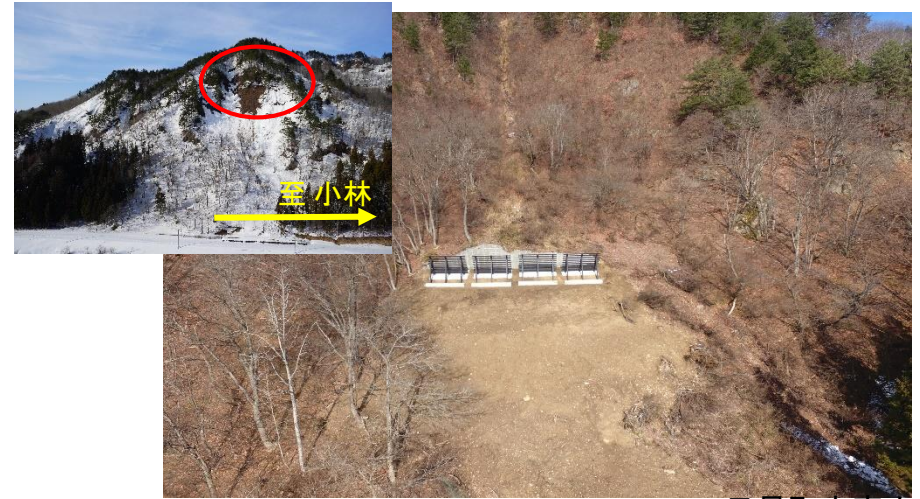
只見町大字小川地内
