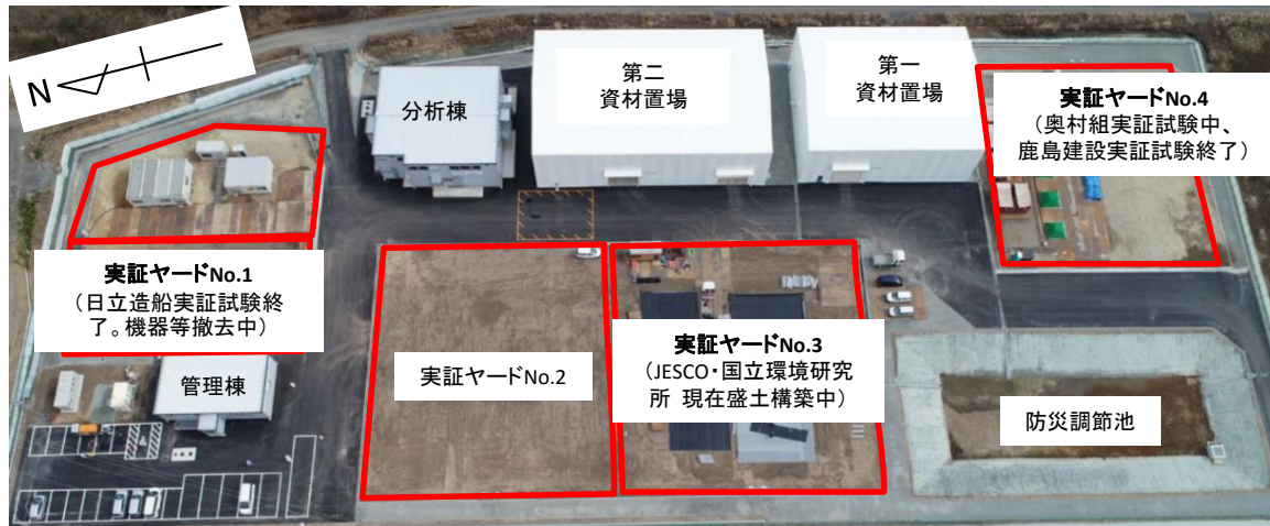
ドローンによる技術実証フィールド全景（2020年2月14日時点）
