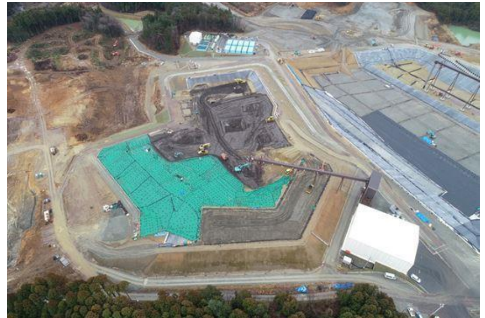
土壌貯蔵施設(西側)
