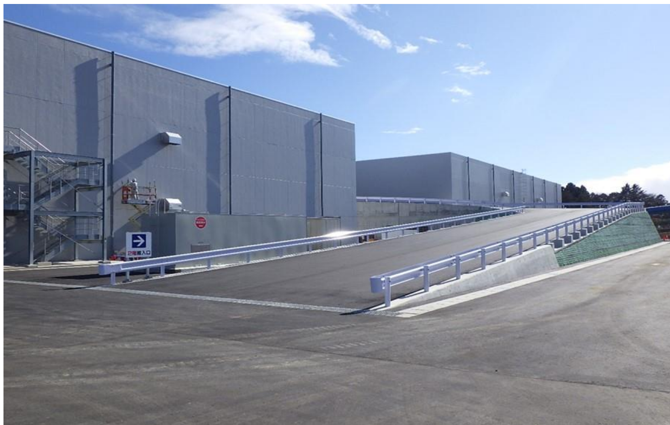
北西側より全景写真・スロープ部施工状況
