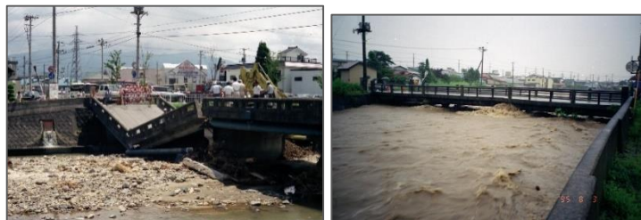
平成7年の被災状況
