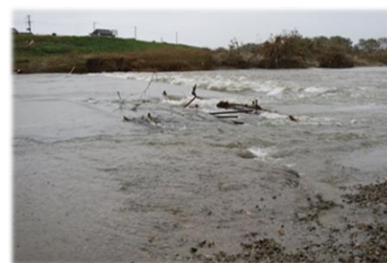
(夏井川の築場の被災直後の状況) (令和元年10月29日)
