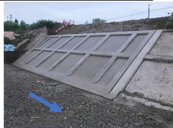
【施工状況（令和2年5月25日撮影）】
