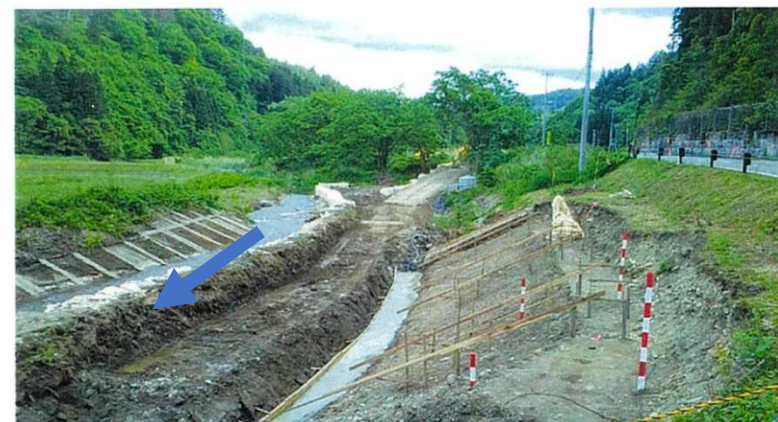
【施工状況（令和2年5月25日撮影）】
