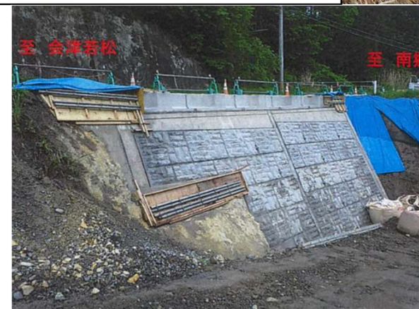
【施工状況（令和2年5月25日撮影）】
