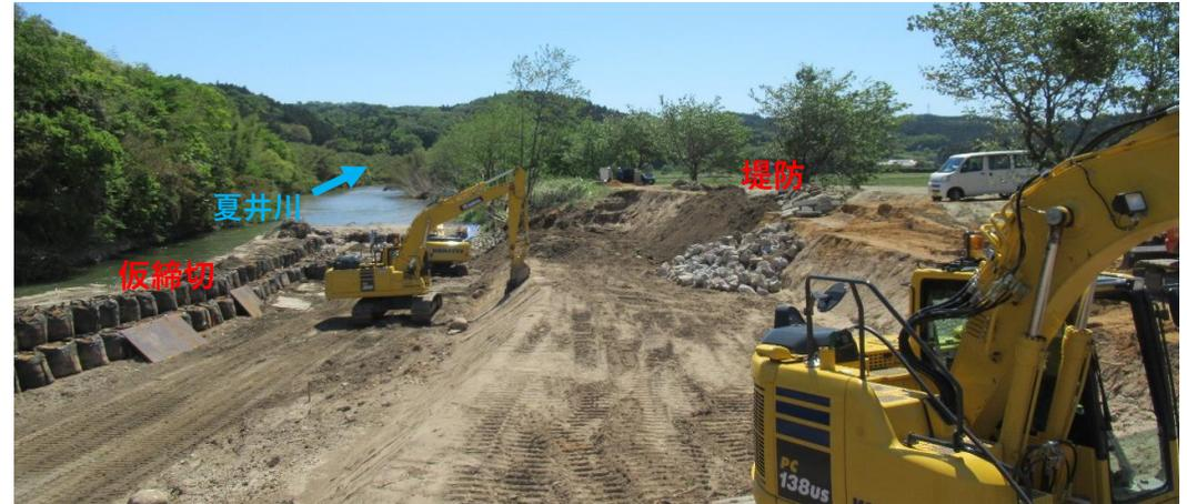
仮締切設置完了、堤防盛土施工中
