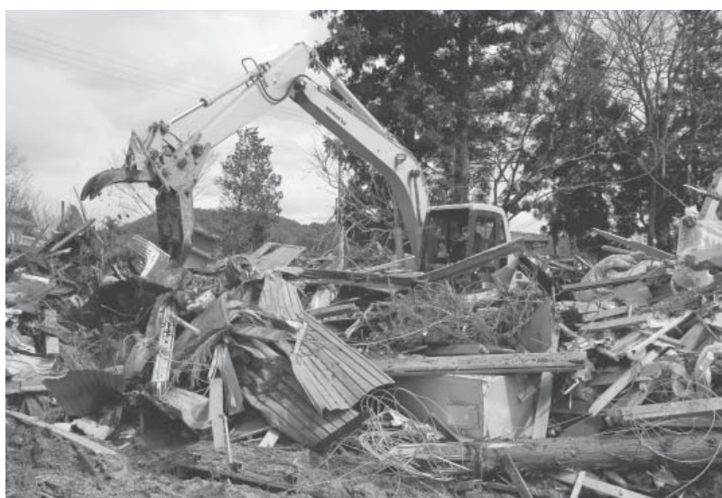
(被災現場の災害復旧 長沼滝地内)
