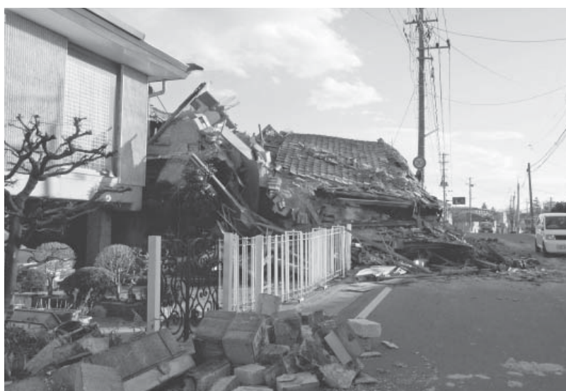
(家屋の被災状況 南町地内)
