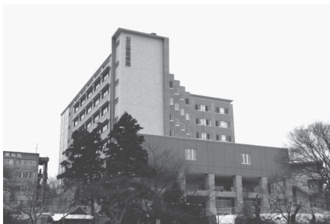
(公立岩瀬病院新病棟)
