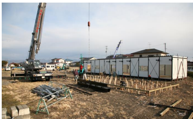
県内で最も早く着工した応急仮設住宅（駅前）
