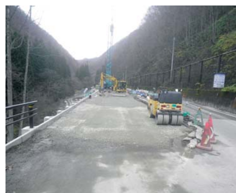
施工状況（国道401号）
