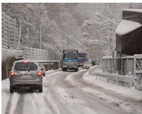
冬期交通支障状況（国道118号）
