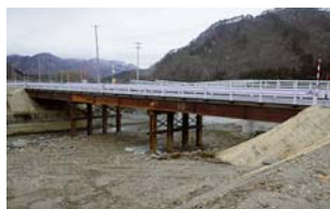
H23.11.11応急復旧完了 (通行止め解除)
