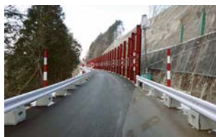
H23.12.22応急復旧完了 (通行止め解除)
