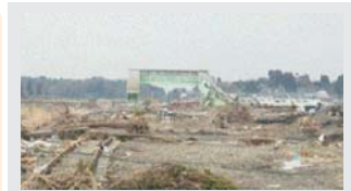
津波により被災した鉄道施設（JR常磐線新地駅付近）
