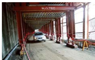
H23.10.17応急復旧完了 (通行止め解除)
