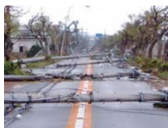
台風で倒壊した電柱（出典：国土交通省）
