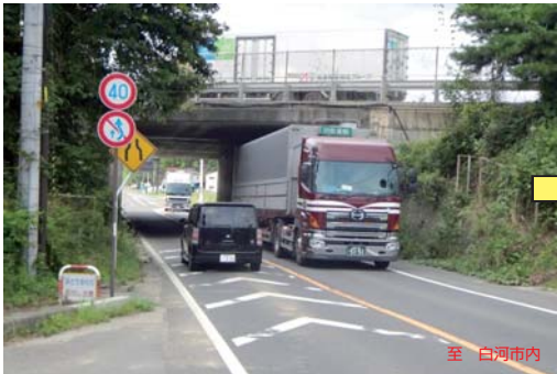
国道294号 (豊地工区) の現道状況
