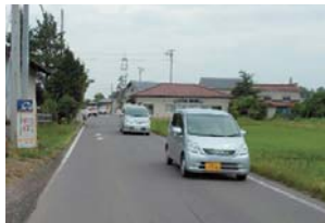
梁川霊山線 薬師前工区 (伊達市)
