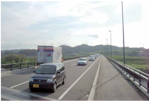
国道288号 (富久山バイパス) の整備状況
