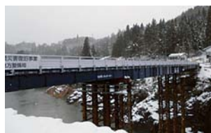
H23.12.20応急復旧完了 (仮橋供用開始)
