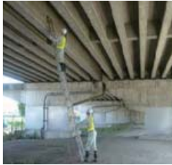
橋梁の定期点検実施状況
