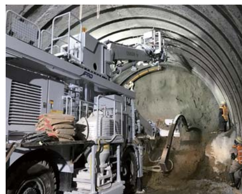
施工状況（国道118号）
