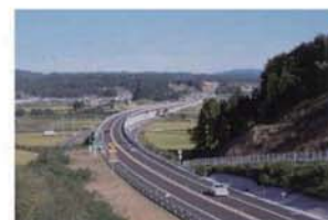
福島空港道路
