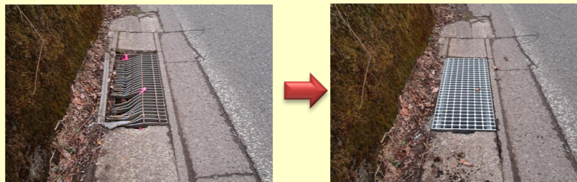
壊れたグレーチングの交換
