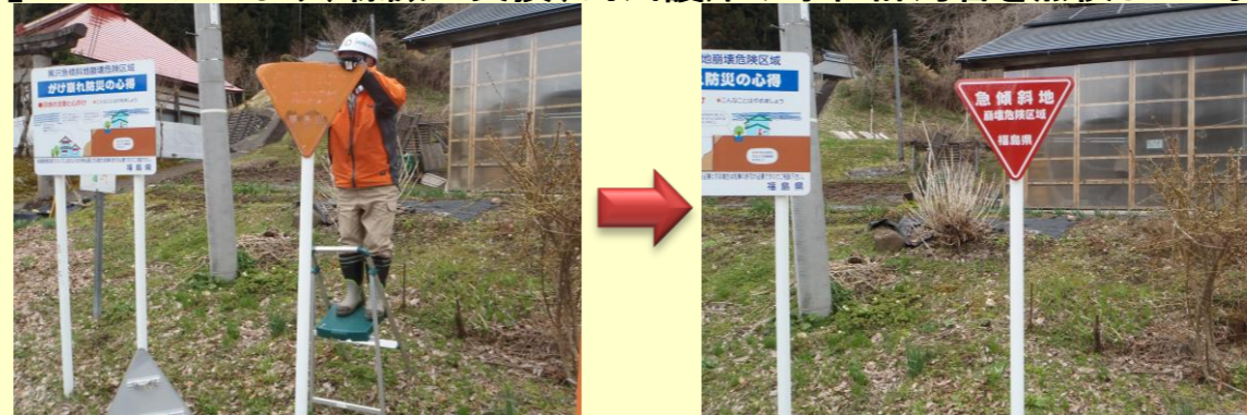
急傾斜地標識の交換
