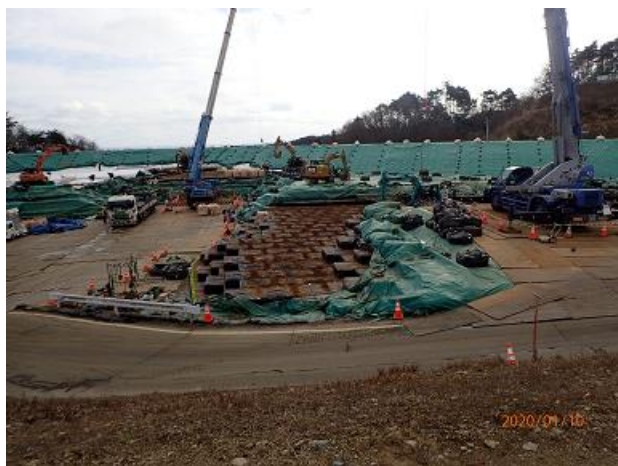
下流側埋立地の埋立状況の確認
