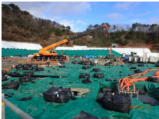
上流側埋立地の埋立状況の確認
