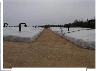
伐採木一時保管槽
