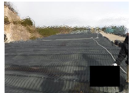
ジオグリッド敷設後の様子
