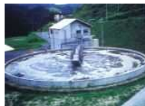
畜産環境対策施設
