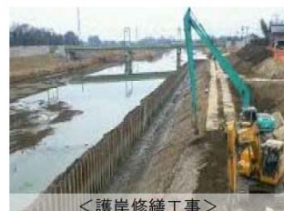
事例：小規模な護岸修繕工事
