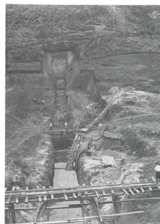
中心床掘状況
