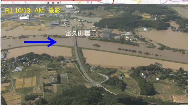
②富久山橋付近(81kp付近)
