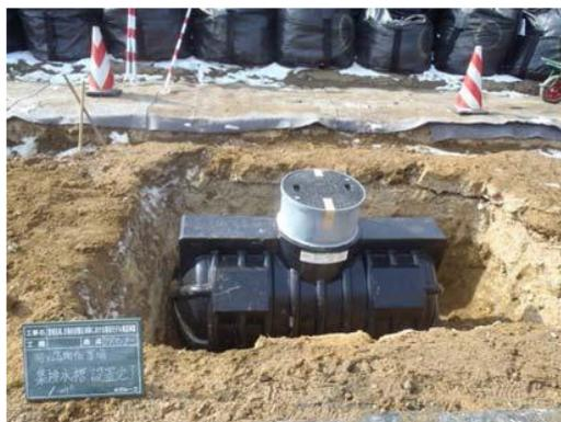
図 2-24 集水タンク（放射性物質確認用）の例
