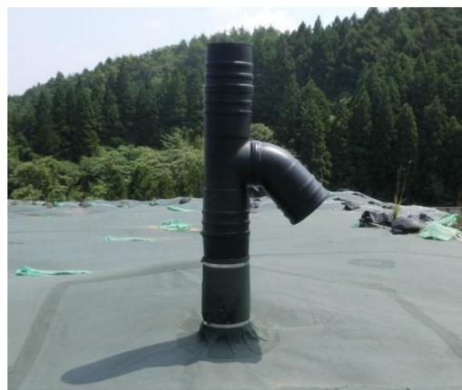
ト型ガス抜き管基礎接合部の例
