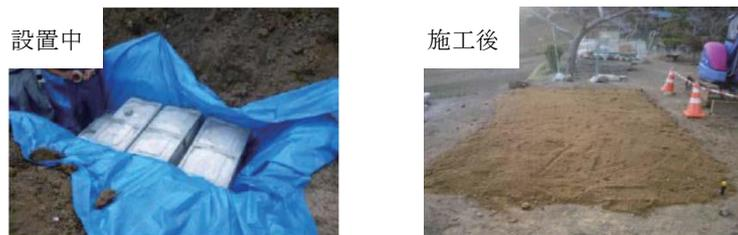
図 4-2 現場保管（地下保管）の例
