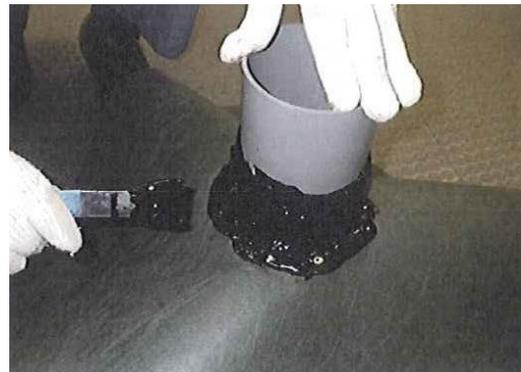
アスファルト系ホットメルト接着剤による固定例
