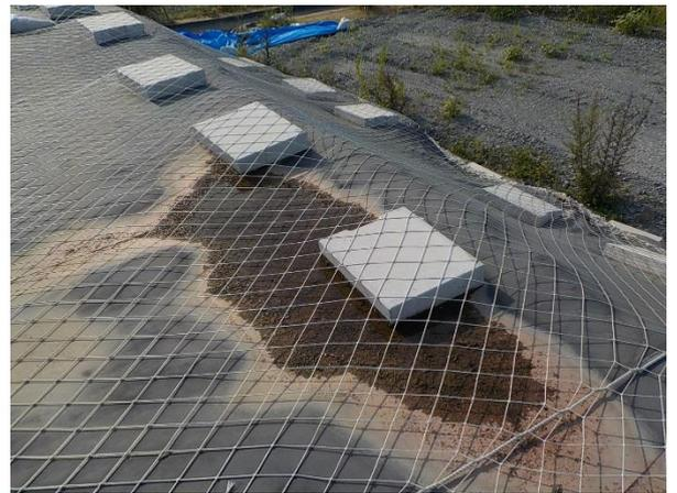
図 2-21 防風ネットによる養生例
