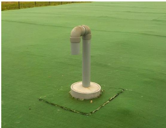
ガス抜き管基礎接合部の例
