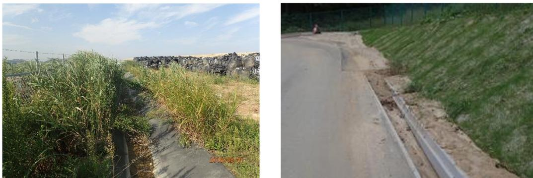
図 3-6 雨水排水設備に土砂が堆積した例
