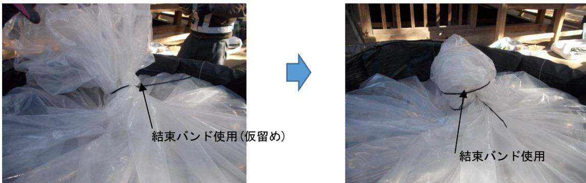
図 2-10 内袋 2 枚目の縛り方の例
