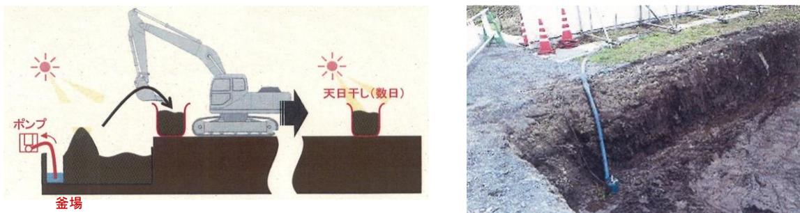
図 5-13 釜場による集水、天日干し例
