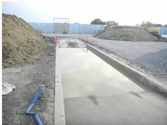
図 2-33 タイヤ洗浄設備の例
