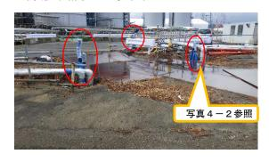
(写真4-1)北東側から撮影赤丸部分に3本ずつ残置配管がある
