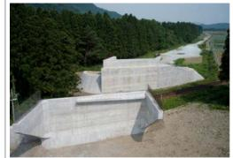
本工事は、会津鉄道を跨ぐ跨線橋の下部工及びブロック 積の工事である。大型コンクリート構造物の有害なひび割 れを防止する誘発目地の自主施工や、困難な曲線部のブ ロック積の施工は高度の技術力を示している。
