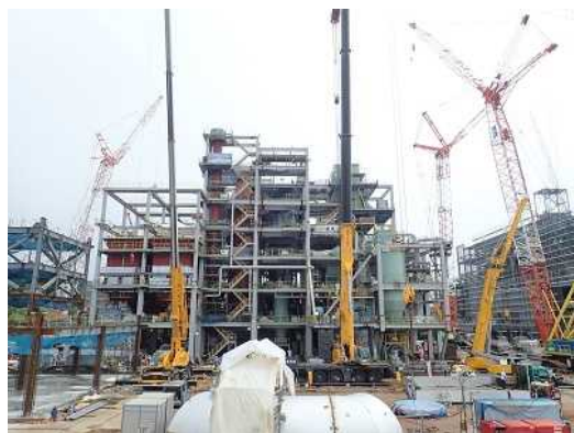
仮設焼却施設：機器据付
