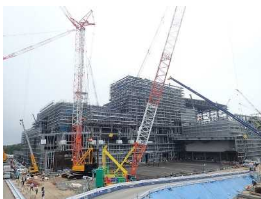
仮設灰処理施設：機器据付
