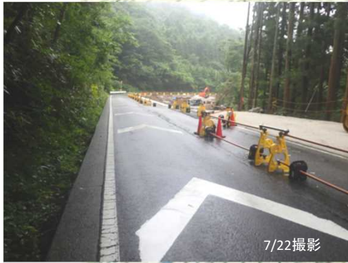
①工区伐採完了
