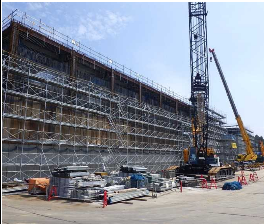
北西側より全景写真・定置場①壁型枠設置状況
