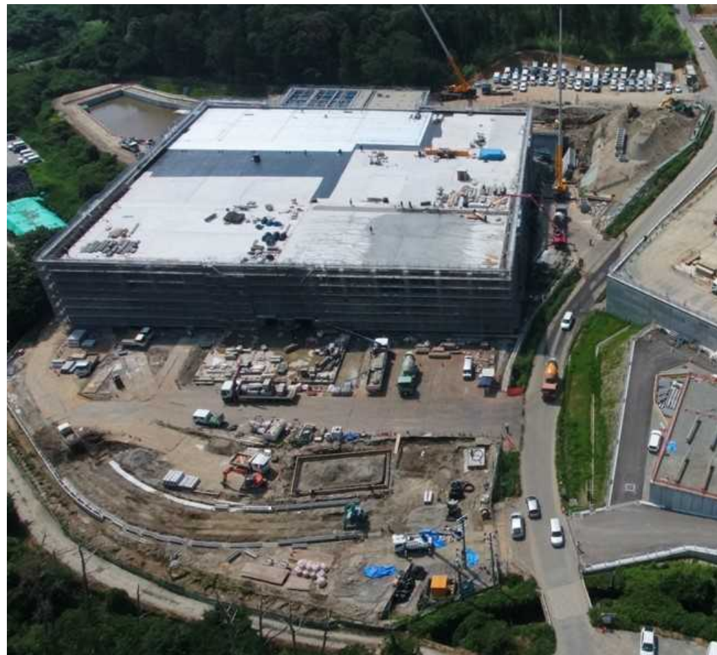
北側（写真下）より屋上工事及び外構工事状況
