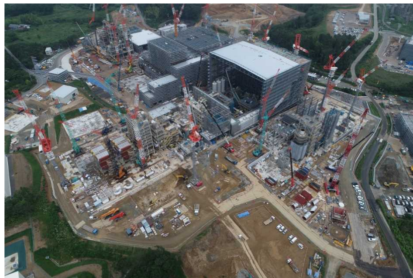
ヤード全景：7月19日現在
