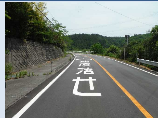
改良工事後の道路の様子(国道288号)
