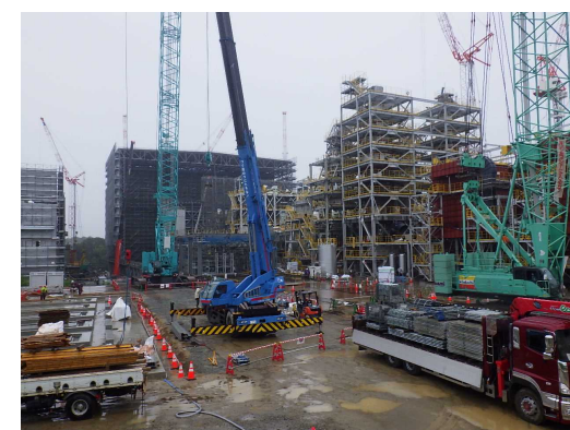
仮設灰処理施設：機器据付
