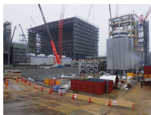
仮設焼却施設：機器据付
