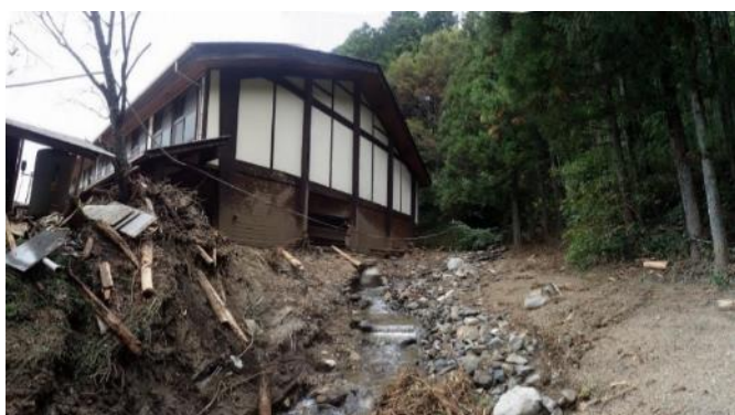
林地被害 「おふくろの宿（体育館）」（田人町旅人地内）
