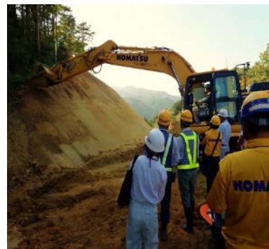
ICT 建機のバックホウによる掘削作業風景
