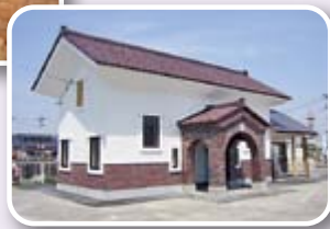
▲れんがを活用した施設。
