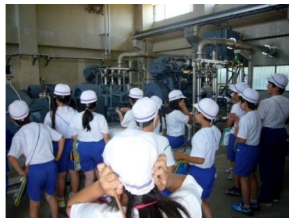
(大越藤間第2排水機場見学)
