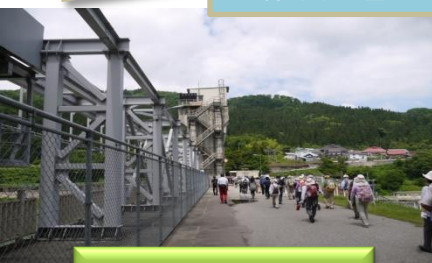
柳津発電所 ダム
