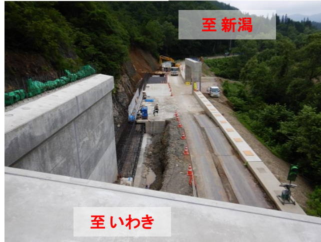
スノーシート工事状況
