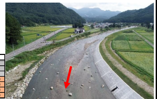
工事完了状況写真 (南会津町伊与戸地内)
