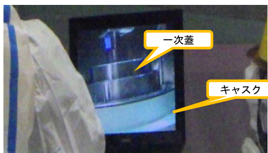
(写真14) 一次蓋取り外しの状況を水中カメラで確認（オペフロ内モニタを撮影）
