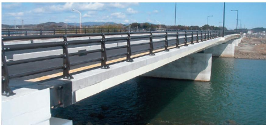
鮫川橋は、いわき市植田町地内の二級河川鮫川に架かる橋梁である。桁高を低く抑え、主桁本数を少なくするために「鋼殻合成床版」を採用し、コストの縮減を図った。
