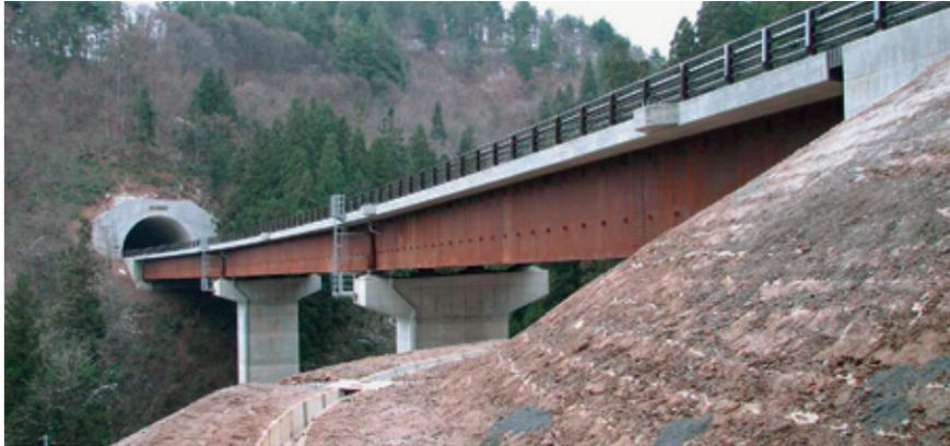
本橋は、国道121号 喜多方市熱塩加納町熱塩地内に架かる橋であり、国道121号大峠道路のバイパス工事により、新設した。道路が曲線であるなか、主桁を直線折れ形状とすることにより、構造を単純化し、合理化・省力化・施工性の向上を図った。
