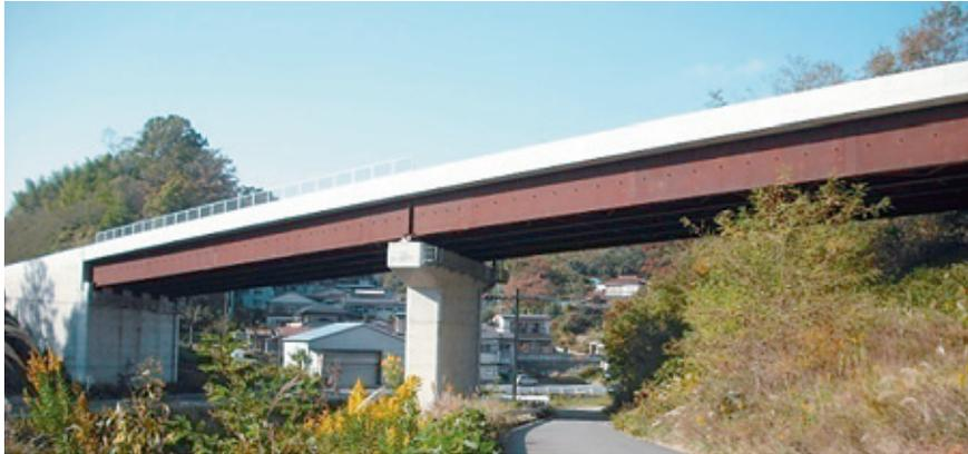
本橋は、一般国道288号三春西バイパスの整備に伴い新設された田村郡三春町字一本松地内の桜川・現道288号に架かる橋であり、橋桁には耐候性鋼材を用いた。
