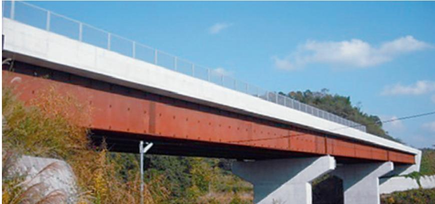
本橋は、一般国道288号三春西バイパスの整備に伴い新設された郡山市西田町字中野内地内の八島川・JR磐越東線に架かる橋であり、橋桁には耐候性鋼材を用いた。
