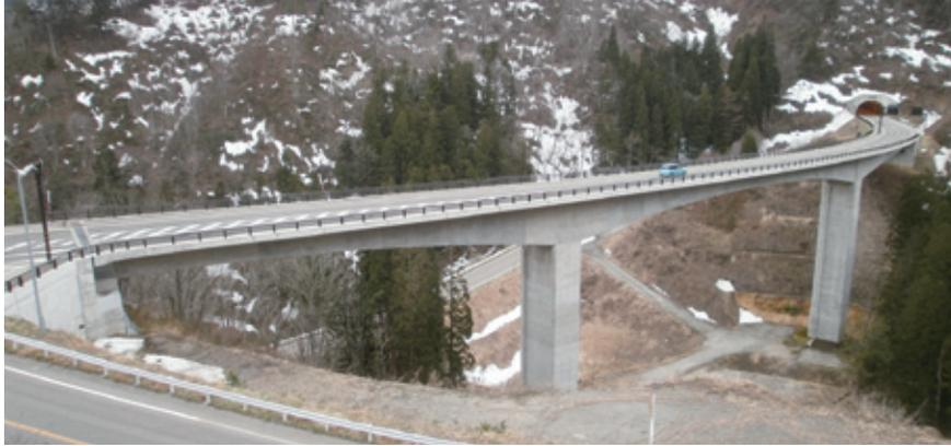
本橋は大峠道路（福島県事業区間）の米沢側に位置する、PC3径間連続ラーメン橋である。深い渓谷を跨ぐため、上部工はカンチレバー工法で架設し、橋脚は大口径深礎基礎を有する鋼管コンクリート複合構造橋脚としている。
