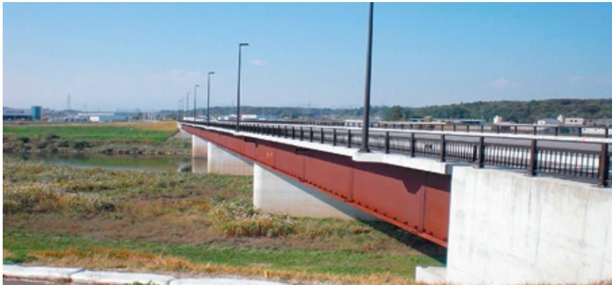
本橋は、一般国道288号の富久山バイパスの一環として阿武隈川に架けられた橋梁である。支承レスによる維持管理費及び施工費の低減、耐震性の向上のため、桁と橋脚を一体化する複合剛結構造としている。
