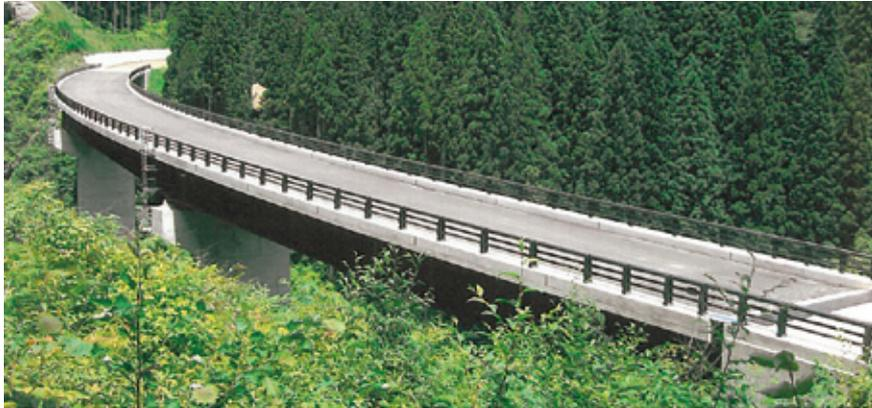
本橋架設にあたっては、R=300m曲線で縦断勾配6%、横断勾配5%の線形の中、各施工段階でカンバーや床版の張出量等の管理を徹底し、また、橋長152mの長大橋にかかわらず工場で一括仮組立を実施し、出来型精度の向上に努めた。
