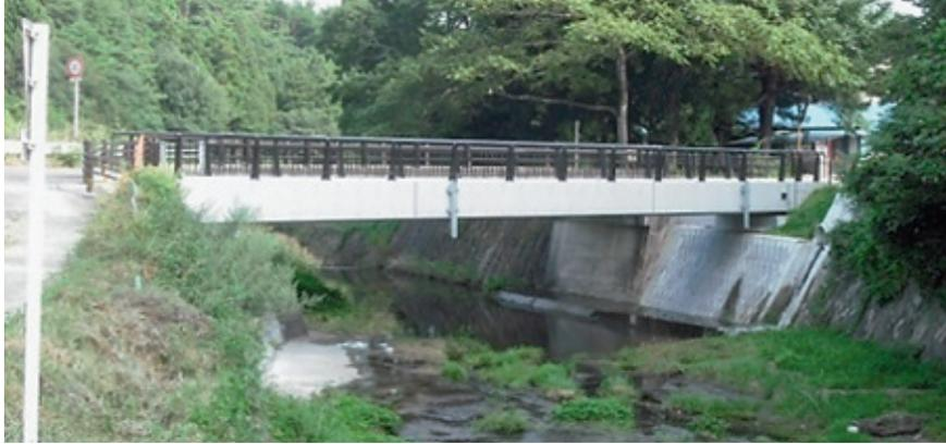
本橋は、須賀川市滝字大新畑地内の箕ノ子川に架かる歩行者用橋梁である。本箇所は長沼小学校の通学路となっているが、既設橋梁に歩道が設置されておらず、通学に危険な状態であったため、側道橋を設置し歩行者通行の安全を確保したものである。
