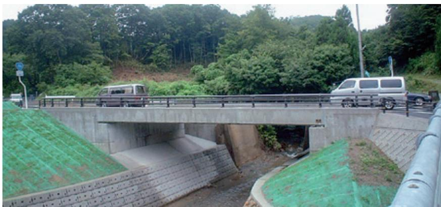
小倉沢橋は、昭和13年に架設され、架設後68年経過している老朽橋で、幅員は約5.0mと狭く、車両の大型化に伴い、車両のすれ違いが困難な状況にあり、これらを解消するため、平成18年度に事業着手し、平成19年度に工事の完成を図った。
