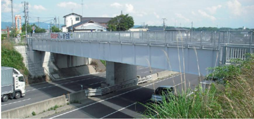
本橋は、須賀川市西川町の東北縦貫自動車に架かる歩行者用橋梁である。本箇所は、須賀川市立西袋第一小学校に近接し、朝夕は、小学生が多数通学しているところであるが、既設橋梁に歩道が設置されておらず、通学に危険な状態であったため、側道橋を設置し歩行者通行の安全を確保したものである。
