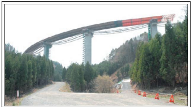
《送り出し装置のメカニズム及び送り出し状況写真》
