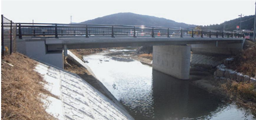
本橋は、東白川郡埴町大字常世北野地内の赤坂川に架かる橋梁である。旧橋は、幅員が狭く通学路に指定されているにも関わらず歩道が未整備のため非常に危険な状態になっていたため、赤坂川の河川改修にあわせて河川事業との合併施工により架替工事を行ったものである。
