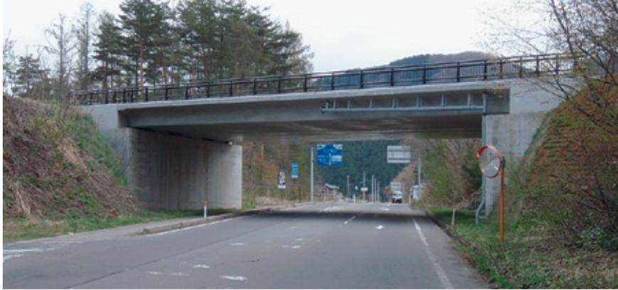
本橋は、国道121号 喜多方市熱塩加納町加納地内の県道熱塩加納山都西会津線に架かる橋であり、国道121号大峠道路のバイパス工事により、新設した。中空床版橋とすることにより、コンクリート重量を減らし合理化・省力化・経済性の向上を図った。
