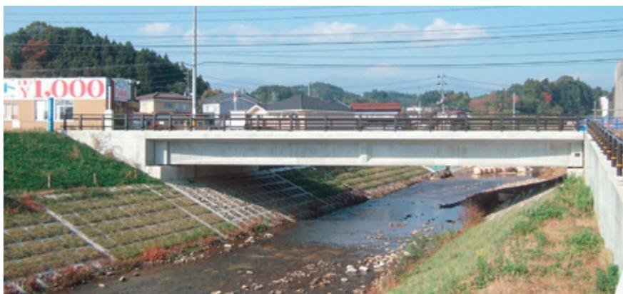
本路線は、福島市蓬莱町と二本松市を結ぶ一般県道である。本橋は、総合流域防災事業（油井川）に伴い、架替えをしたものである。上部工は、架設桁併用トラッククレーン架設工法により、施工を行った。
