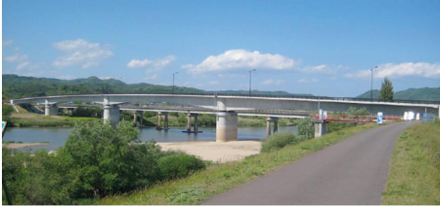
本橋は、県北北部と宮城県を結ぶ国道349号の阿武隈川に架かる橋梁である。交通量の増大と車両の大型化により老朽化が進み、また、歩道もないことから歩行者の通行の支障にもなっているため架け替えを行った。橋台は国土交通省が施工し、橋脚、上部工を県が施工している。
