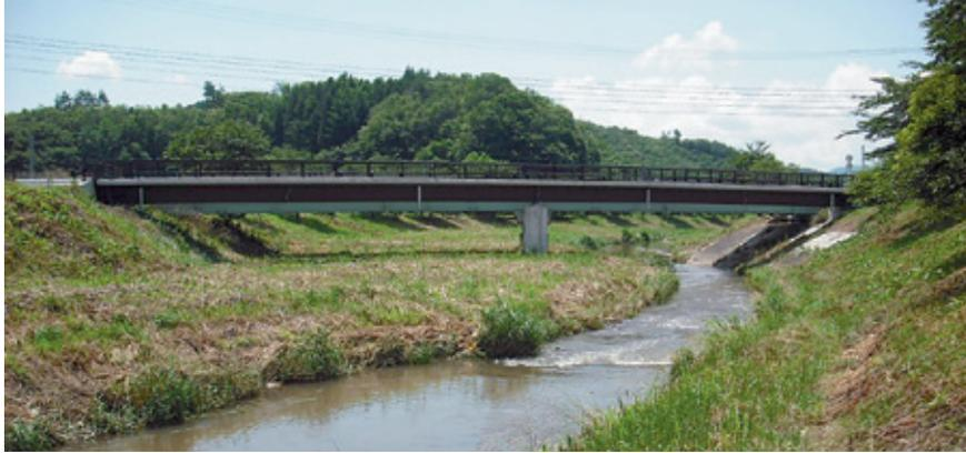
本橋梁は、船引市街地縁辺部に位置する国道288号の大滝根川にかかる歩行者用橋梁である。本箇所は、自動車交通、歩行者等の交通も多いため、安全かつ円滑な交通を確保のため一般部の歩道整備と併せて側道橋を整備したものである。
