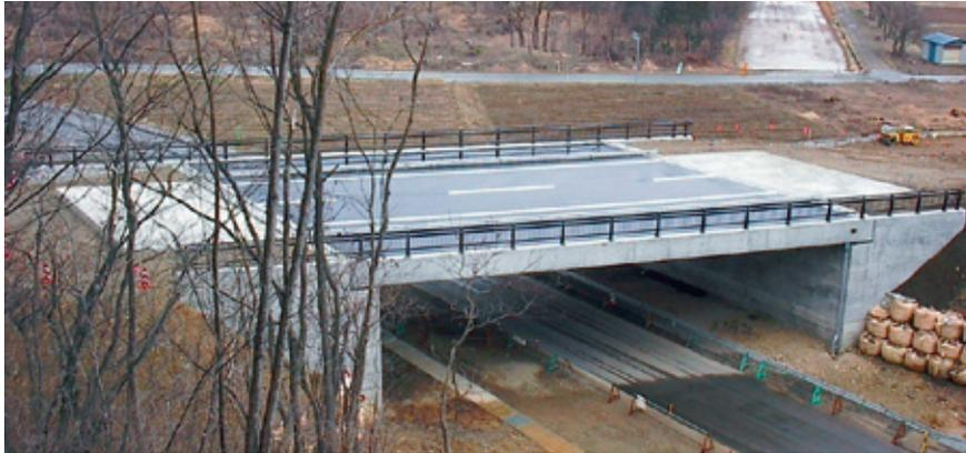
本橋は、国道121号 喜多方市熱塩加納町加納地内の市道五目赤崎線に架かる橋であり、国道121号大峠道路のバイパス工事により、新設した。中空床版橋とすることにより、コンクリート重量を減らし合理化・省力化・経済性の向上を図った。
