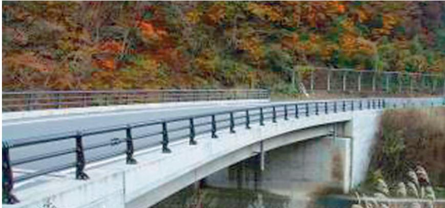
本橋は、国道459号 喜多方市山都町蓬萊地内の宮古川に架かる橋であり、現道の幅員狭小を解消する目的で、架替工事を行った。中空床版橋とすることにより、コンクリート重量を減らし合理化・省力化・経済性の向上を図った。
