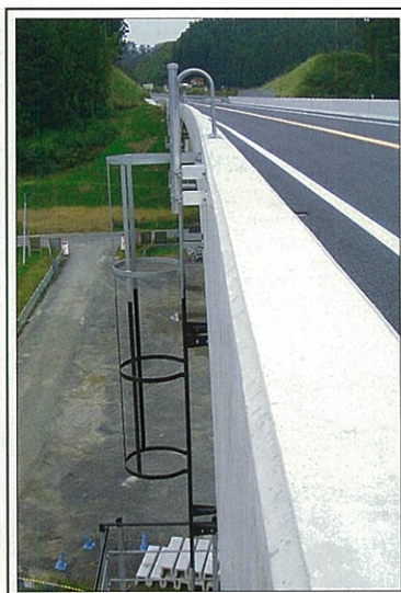
検査路の着色〔写真7〕
