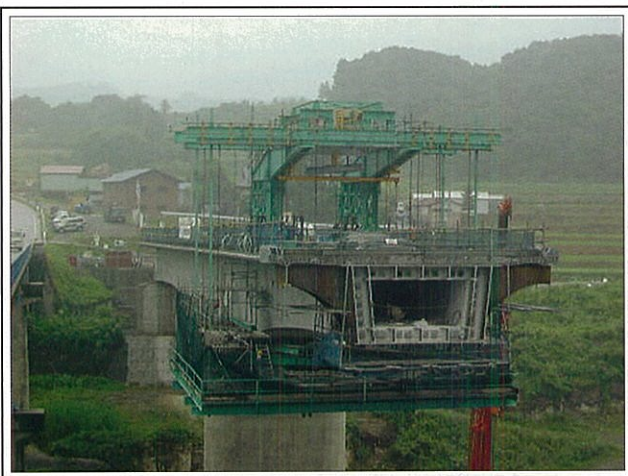
PC箱桁部（固定支保工架設＋張出架設）
