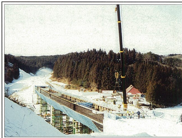
PC床版架設状況〔写真5〕
