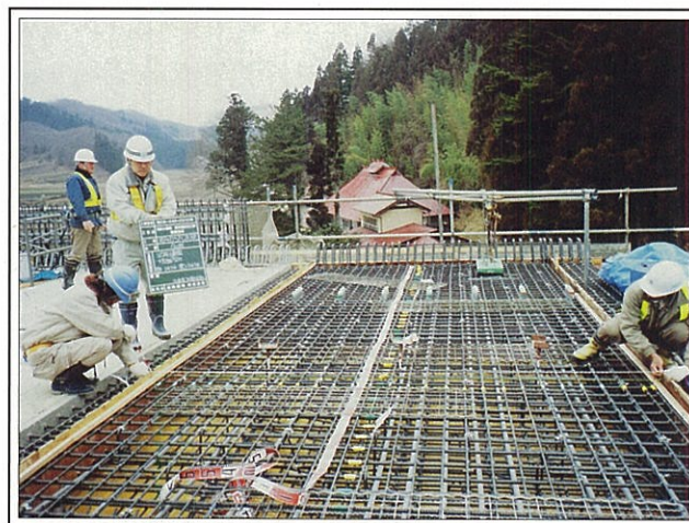
場所打PC床版配筋状況〔写真9〕
