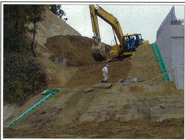
再施工状況〔写真2〕
