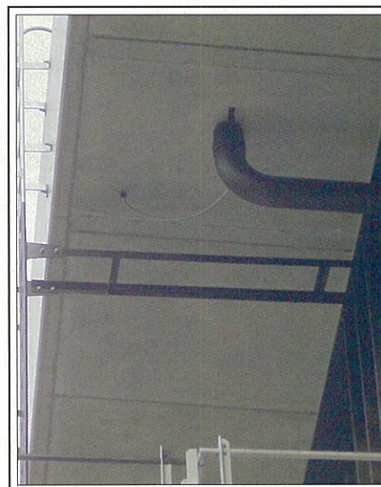
排水管の着色〔写真8〕
