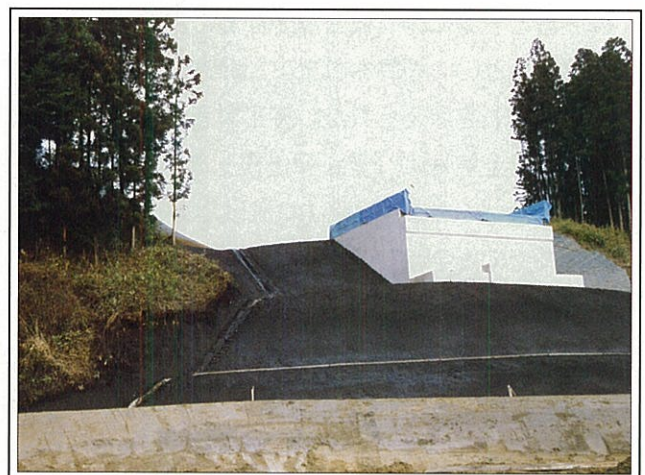
排水工を盛土工端部に施工〔写真3〕
