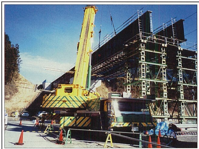
主桁架設状況〔写真4〕
