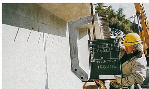
④ ブロック桁の組み立て(2)ブロックの接合2 接着剤塗布後、全ての接合キーが十分に噛み合うまで、各々のブロック桁を引き寄せます。
