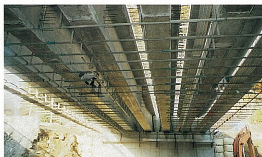
⑦ 横組み工 引き続き、横組み工を施工します。
