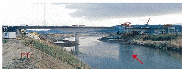
上部工施工状況
