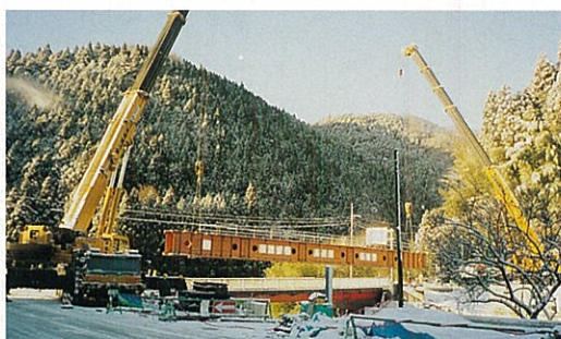
② ブロック組立設備工 ブロック桁の接合・桁の引き出しに用いる架設桁、桁引き出し用台車等を設置します。
