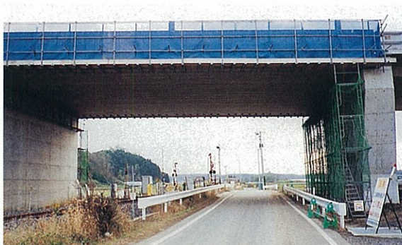
上部工施工状況
