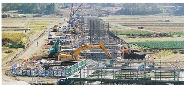
下部施工状況
