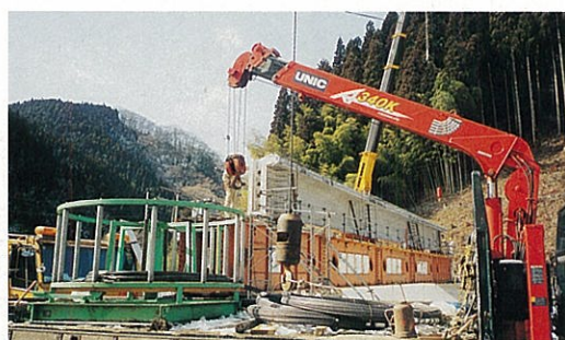
⑥ 架設工 ブロックを架設桁上から、クレーンにより、据付ます。
