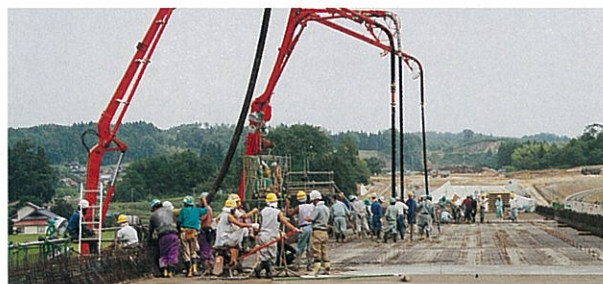
橋面工施工状況
