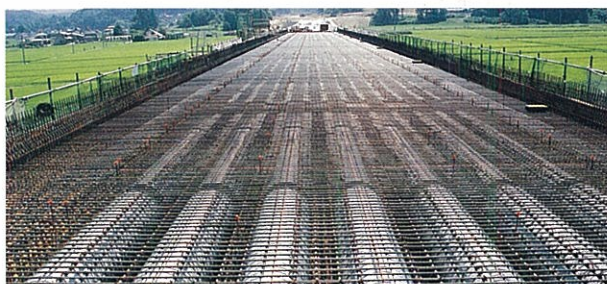
上部工施工状況
