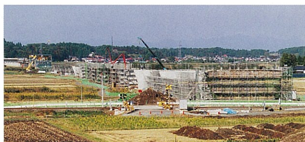
下部工施工状況
