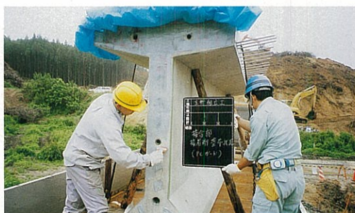
③ ブロック桁の組み立て(1)ブロックの接合 プレキャストブロックの接合面のごみ、油などを取り除き、接着剤を塗布します。
