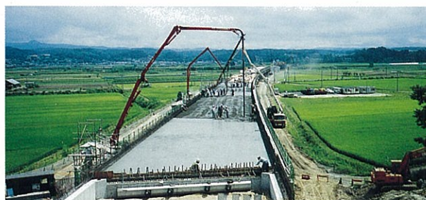
橋面工施工状況
