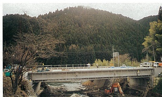
⑧ 完 成 橋面工を施工して完成。
