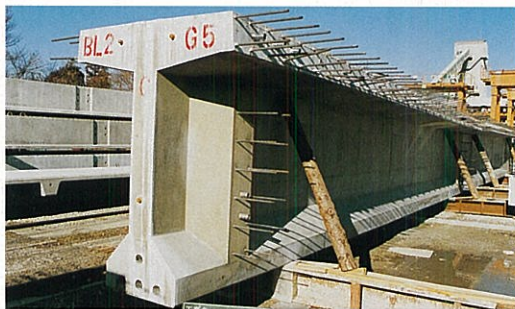
① プレキャストブロック桁の製作 工場において、ブロック桁を製作します。
