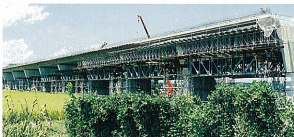
上部工施工状況
