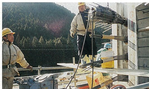
⑤ 緊張工・グラウト工 ブロック接着後、直ちにPCケーブルの緊張を行います。
