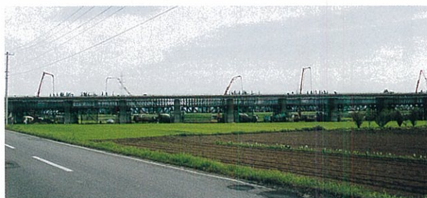
橋面工施工状況
