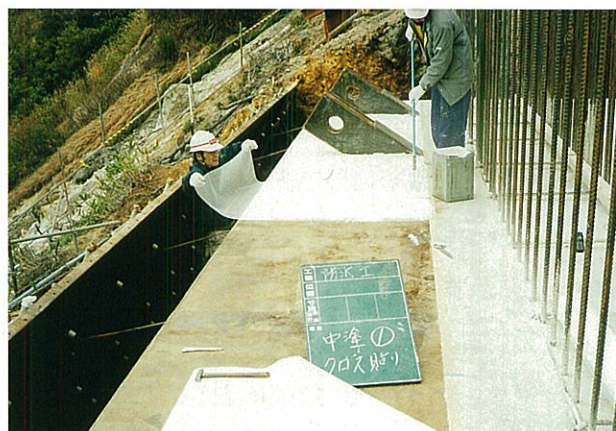
防食材の施工状況
