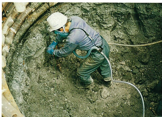
深礎杭坑内作業
