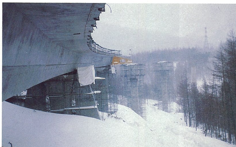
押し架設状況(冬)
