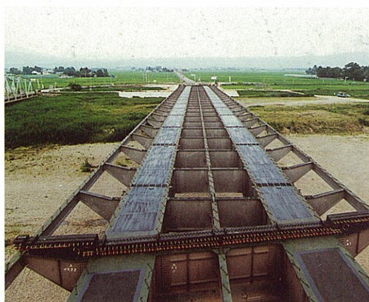
写真⑧ 架設中の新宮古橋。左側が宮古橋。
