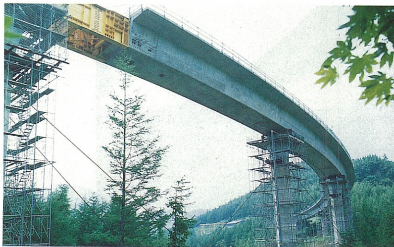
押し架設状況(夏)
