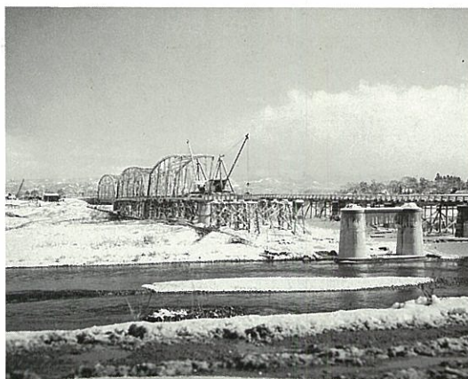
写真⑦ 架設中の宮古橋。三連目の組立作業中である。右側が旧橋。
