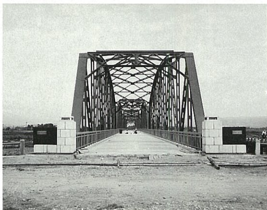
写真⑤ 宮古橋、竣工直前の1枚。右側が旧橋。
