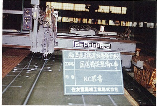
写真⑩ NC罫書き中の写真。製作工場の作業風景はすっかり変わった。 平成4年度完成の俊橋である。
