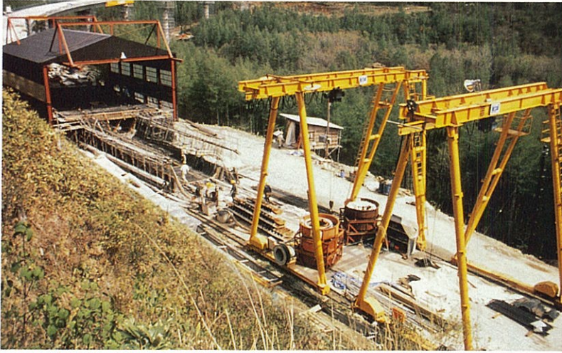
主桁製作ヤード
