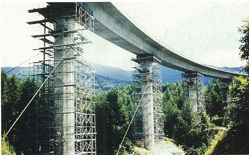
橋脚補強斜材ケーブル
