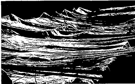
写真⑲ 宮下橋の床版コンクリート電気養生中の写真。「凍結しないように」と記されたコメントに担当者の願いがこめられているようだ。
