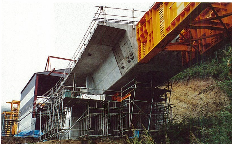
滑り支承及び 横方向制御装置
