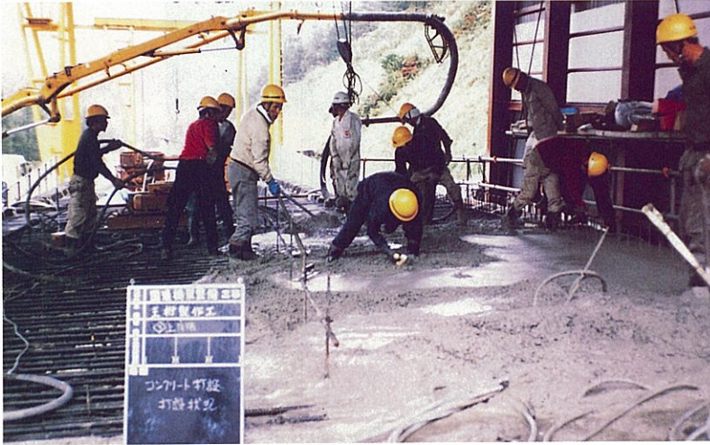
コンクリート打設
