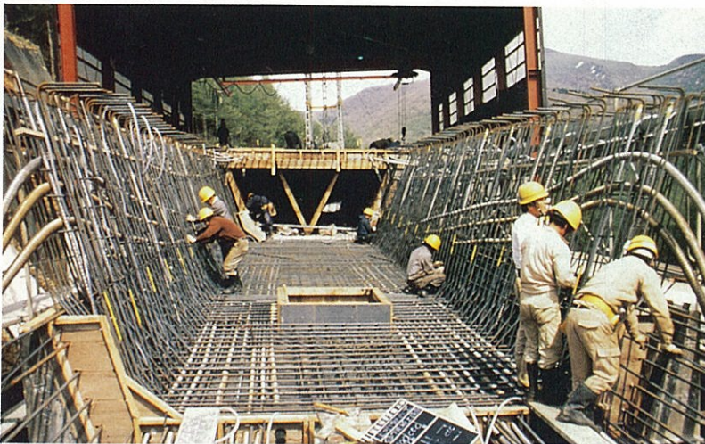
鉄筋・PC鋼材組立
