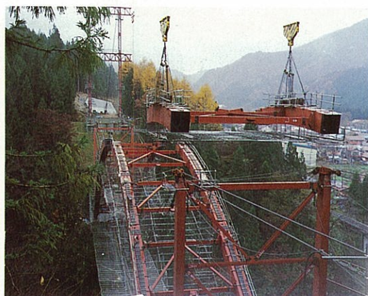
写真④ ケーブルクレーン斜吊り工法で架設中の新宮下橋。
