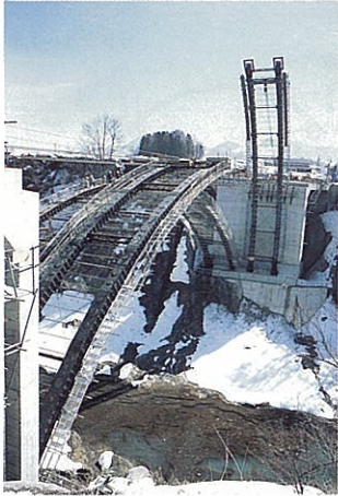
4) 鋼管アーチの架設(3)
