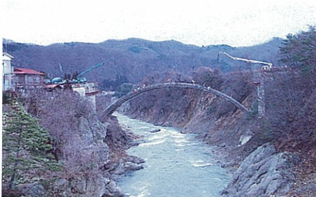
6) 充填コンクリート打設状況
