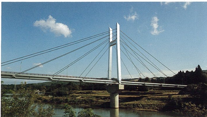
完成なった西羽賀橋
