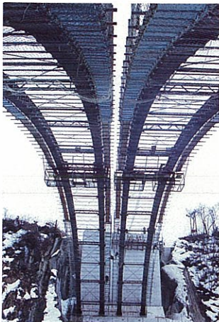
5) 鋼管アーチの架設(4)
