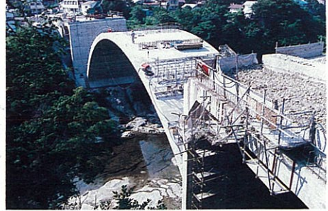
12) アーチリブ完成状況
