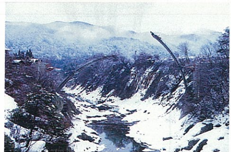
2) 鋼管アーチの架設(1)
