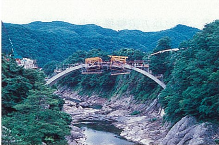
11) 巻立てコンクリート施工状況(2)
