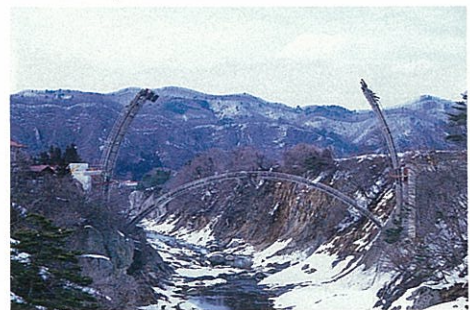
3) 鋼管アーチの架設(2)
