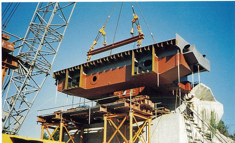
側径間碇着桁架設状況
