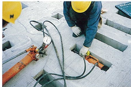
④ 圧縮鋼棒工
