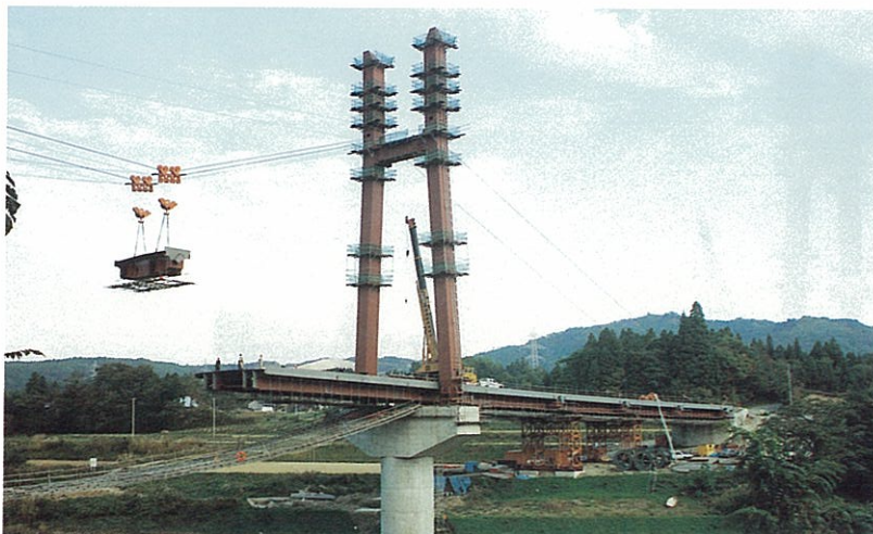
主径間碇着桁架設状況
