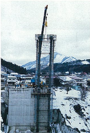
1) 鋼管アーチの建込み
