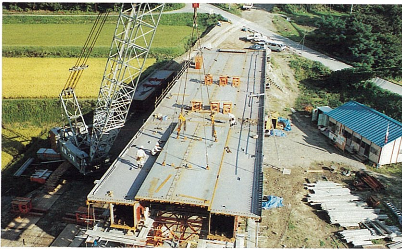
側径間鋼床版架設状況
