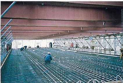
② 床版配筋及圧縮鋼棒配置
