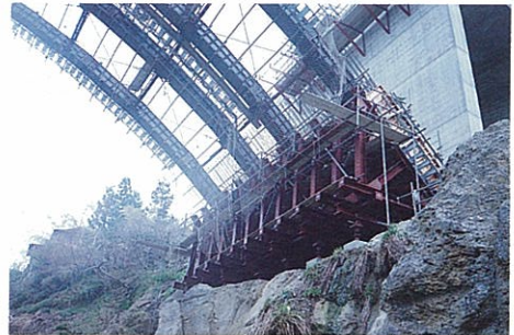
7) アーチリブスプリング部の支保工
