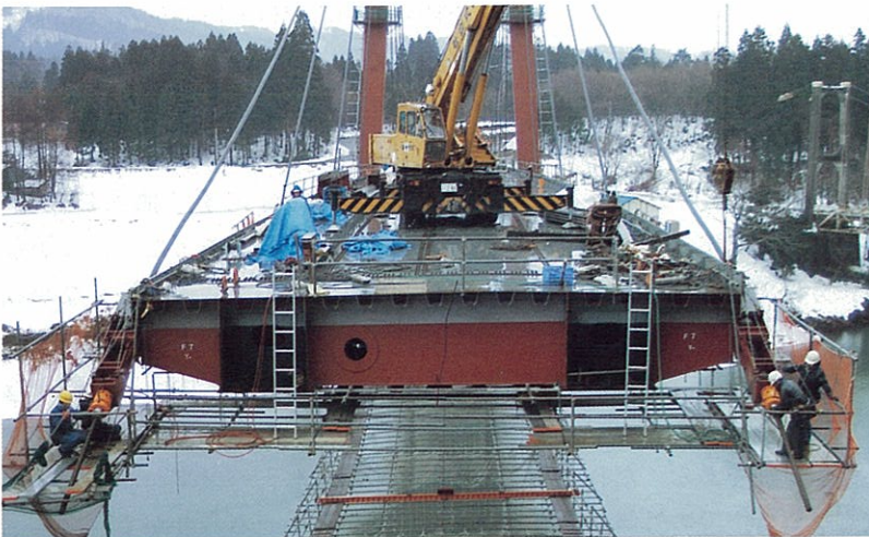
ケーブル桁側 ソケット引込み状況
