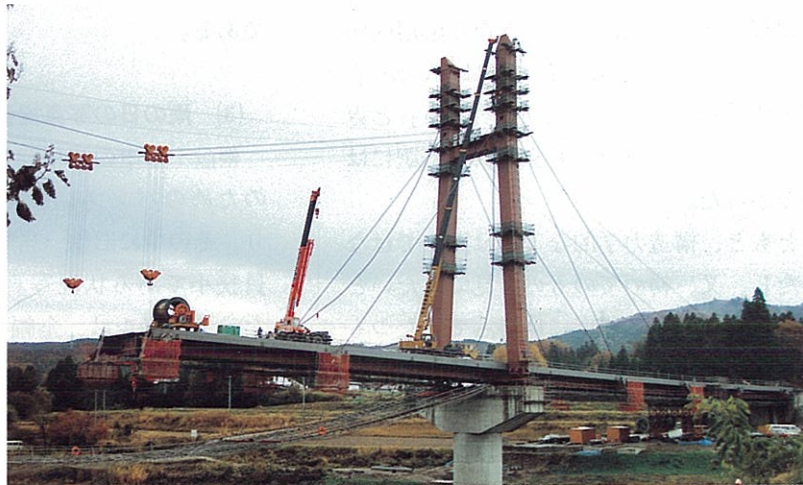
ケーブル塔側 ソケット引込み状況
