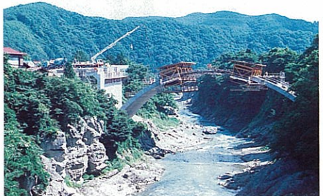
10) 巻立てコンクリート施工状況(1)
