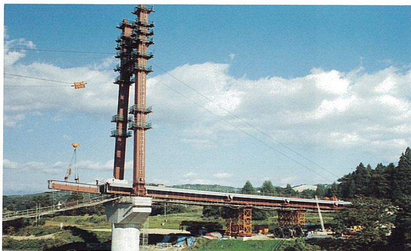
主径間主桁架設状況
