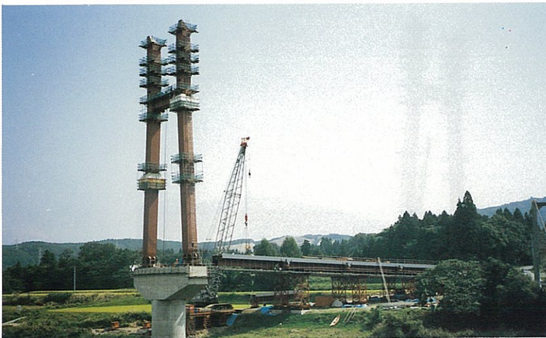
側径間碇着桁架設状況
