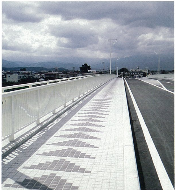
歩道のタイル舗装
