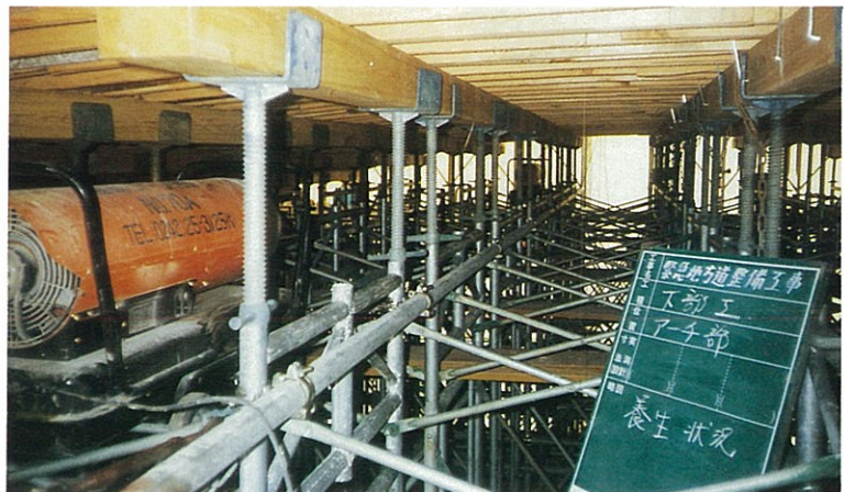
アーチリブ支保工頭部
