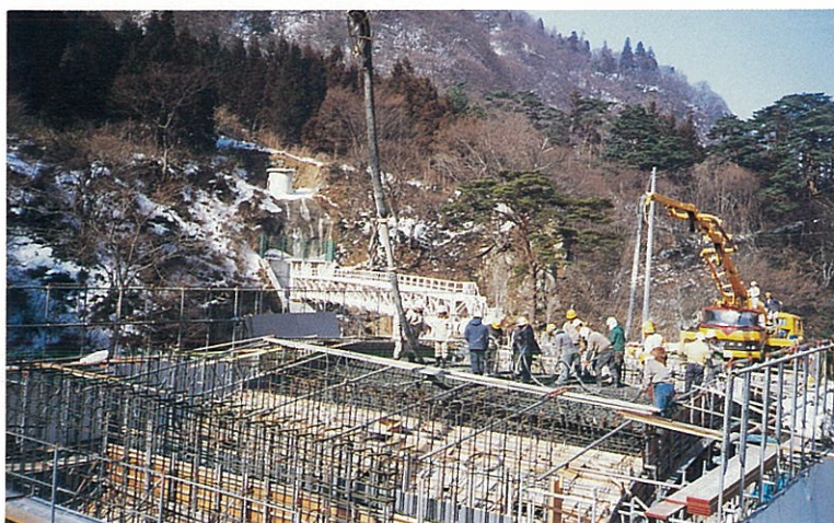
アーチリブコンクリート打設状況
