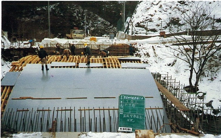
アーチリブ底版型枠組立状況
