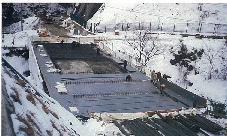
上床版型枠組立状況
