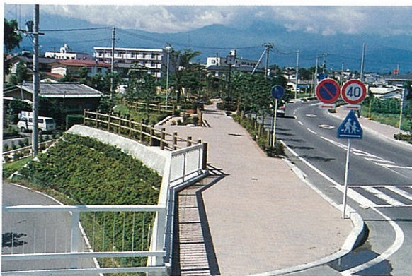
橋詰広場(八木田橋右岸側)
