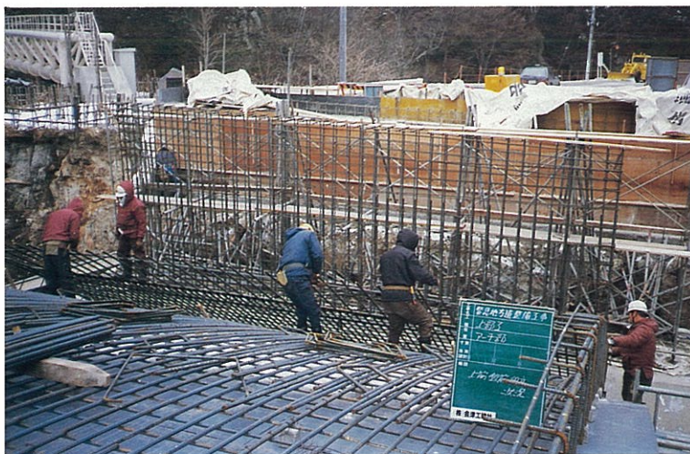
アーチリブ鉄筋組立状況
