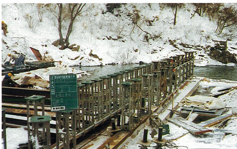
主梁を支える四角支柱
