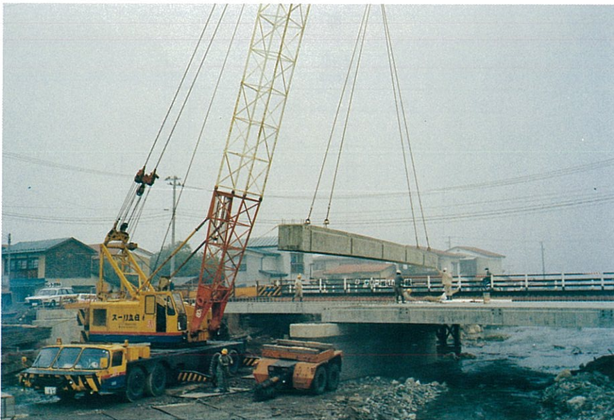
仮橋を利用する不便さをできるだけ短くするため、 プレキャスト桁を用い迅速な施工が行われた。
