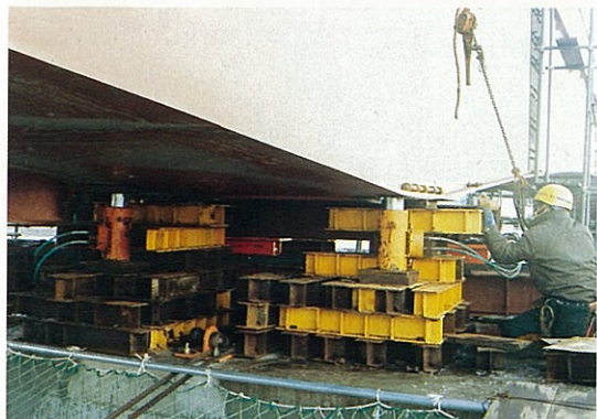
11) ジャッキダウン作業状況
