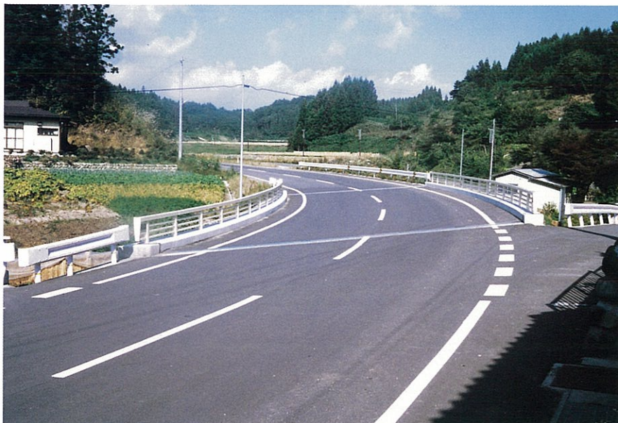
県単独事業で整備された根岸塙線。
