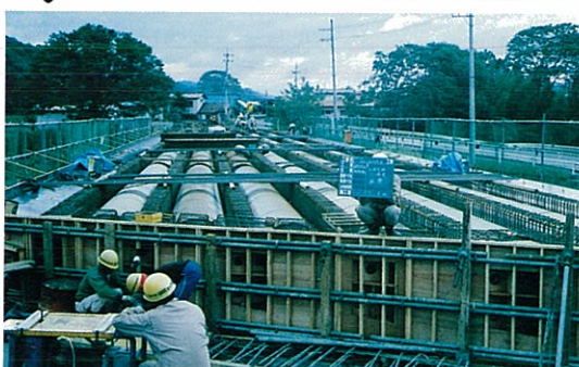
5) 中空型枠設置
