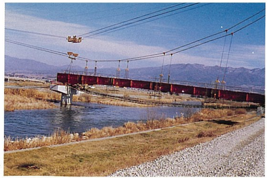
5) A 1 、P 1 間G 2 桁直吊り架設
