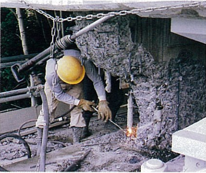
8) 仮沓撤去状況
