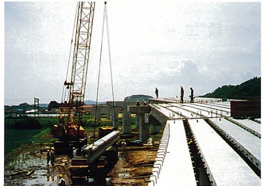
5) ポールトレーラからの吊上げ状況
