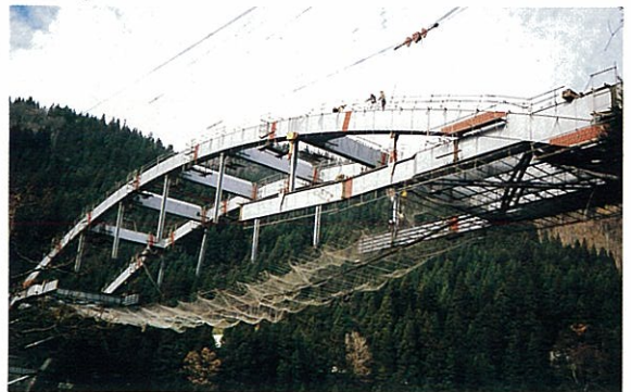
6) 補剛桁の架設(2)
