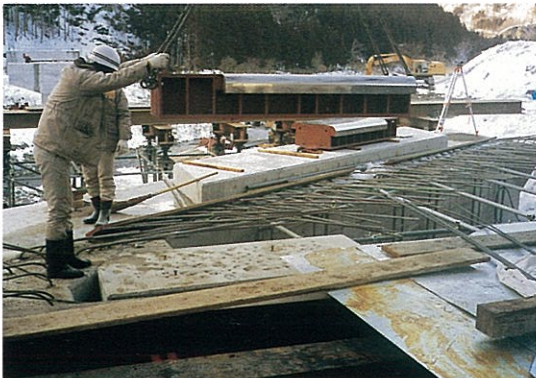
1) 滑り沓の設置状況
