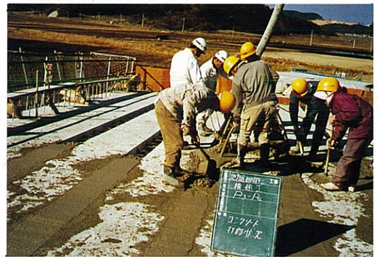
6) 床版打設状況
