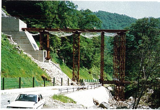
1) ベント設備とレール桁(1)
