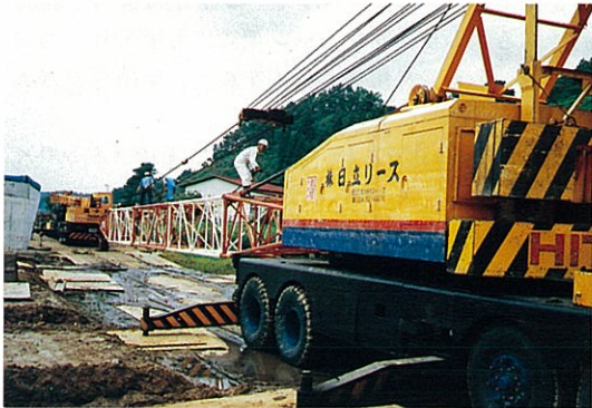
2) トラッククレーン設置状況
