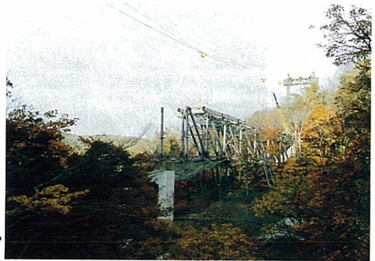
↓ 5) 架設状況 (A 1 ～P 1 間)
