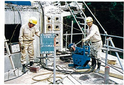
8) 主ケーブル（12-T15.2）の挿入
