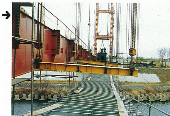
10) G 桁架設状況
