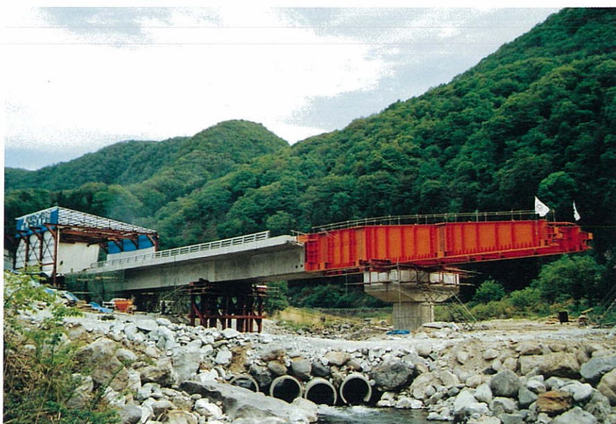
県として初めての押し出し工法が採用された。
