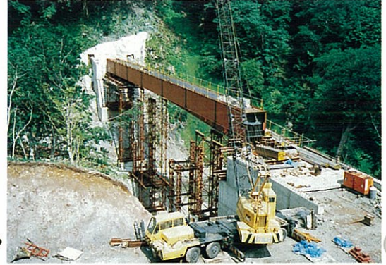
12) G 1 桁送出し完了
