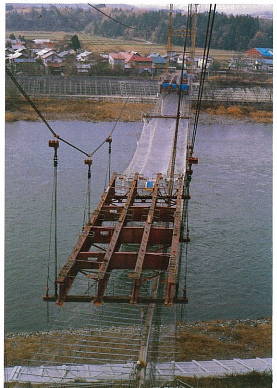
5) 架設状況 (P 3 ~ A 2 間) STEP-2
