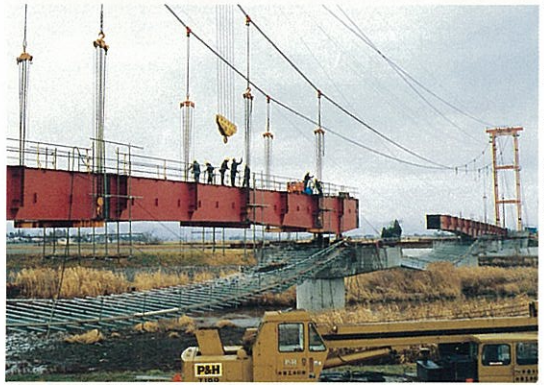
6) 張り出し架設状況
