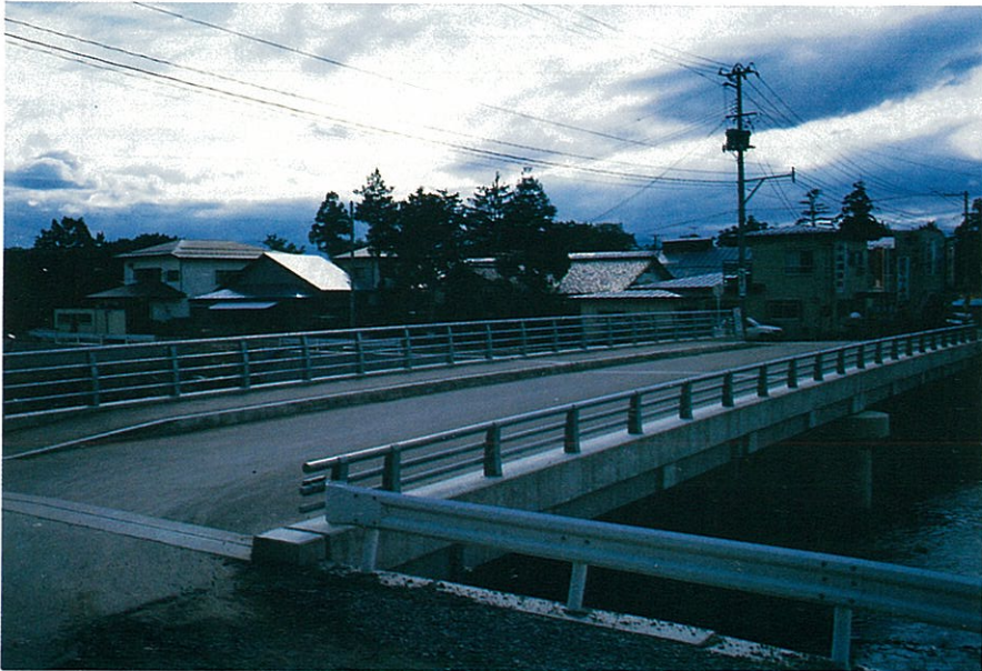
市街地部のため桁高の制約が大きくPCプレテンホロー桁が採用された。
