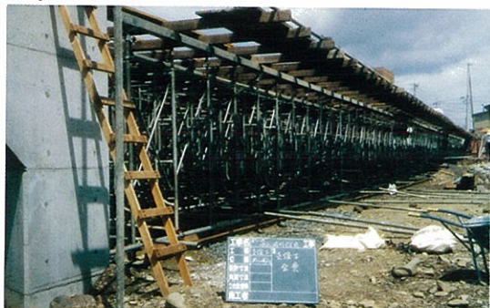
3) 大引き受ジャッキ組立
