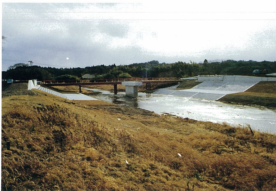
架替工事中は仮橋により交通が確保された。
