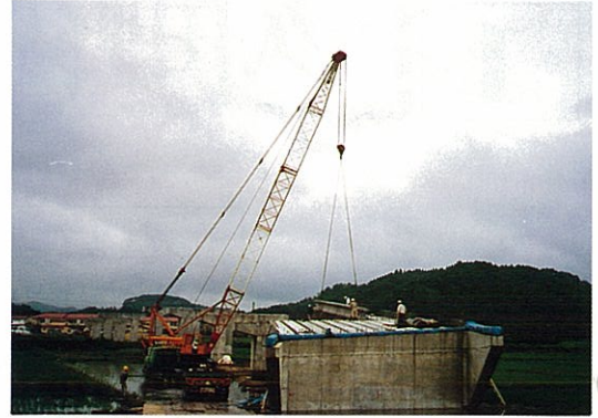
4) 架設状況 (P1~P2)
