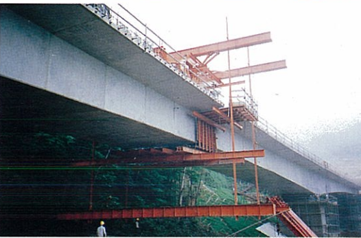
9) 中央閉合部の吊支保工 (ワイゲン撤去前)
