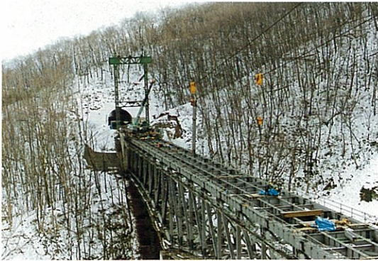
10) 架設部材運搬状況
