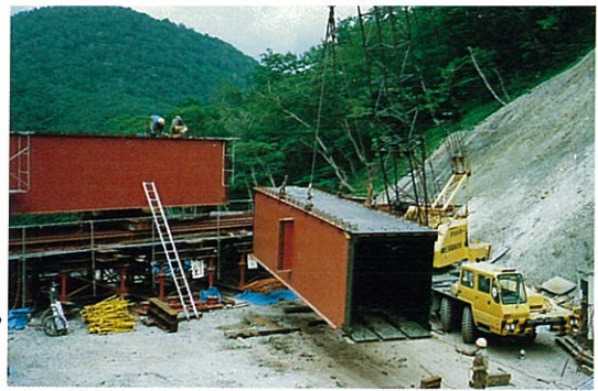
4) G 2 桁地組状況
