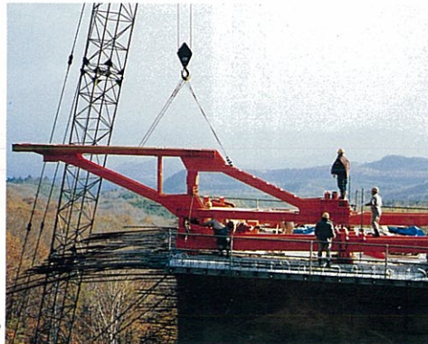
2) ワーゲン組立状況
