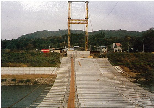
1) ケーブルクレーン直吊り設備とワイヤーブリッジ設備
