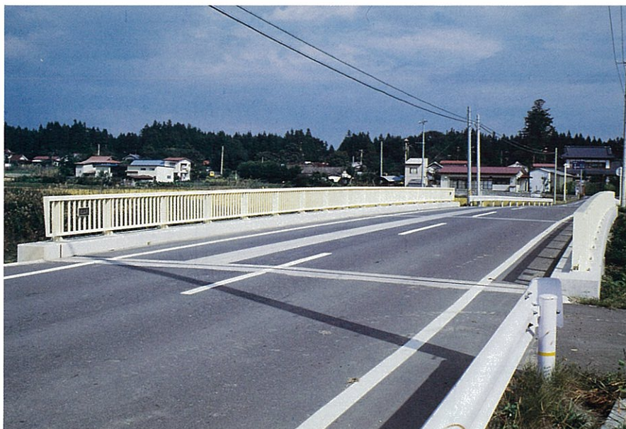
改良工事と合わせ拡幅により整備された桧富橋。
