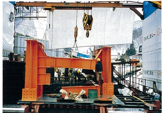
2) 手延桁の組立状況
