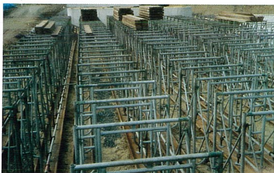
2) ビティー枠組立、大引き受けジャッキ組立
