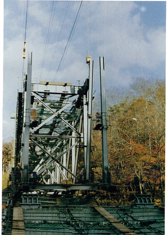
↓ 6) 架設状況 (A 1 ～P 1 間)
