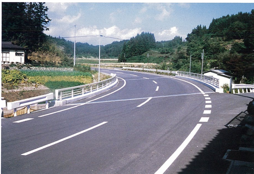
県単独事業で整備された根岸塙線。
