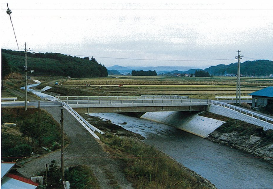
河川との工程調整により工費の節減が図られた。
