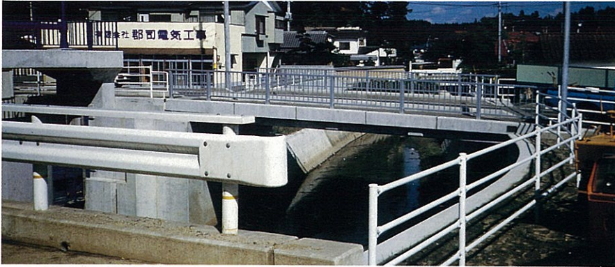
河川改良に合わせ 架替えられた東湖園橋
