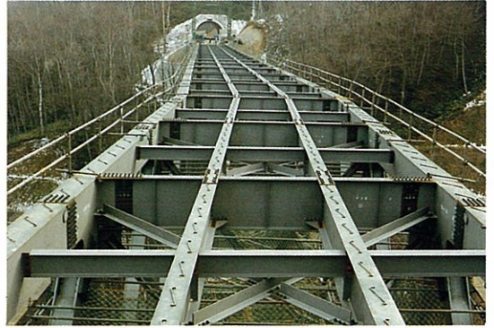
13) 架設完了状況
