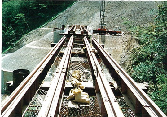
3) レール桁設備設置状況
