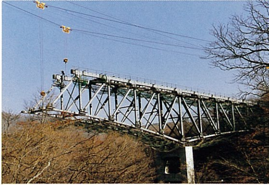
9) 架設状況 (P 1 ~ A 2 間)
