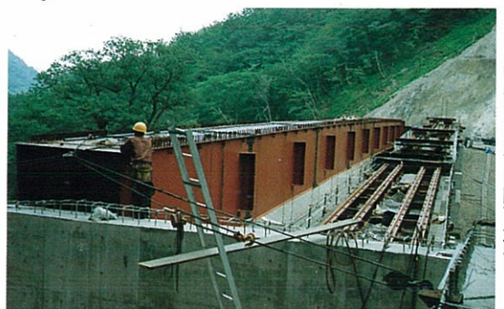
7) G 2 桁送出し完了
