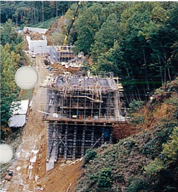
1) 柱頭部の施工状況
