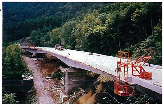
10) ゴンドラによる橋面施工状況
