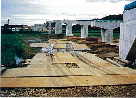
1) 鉄板補強状況
