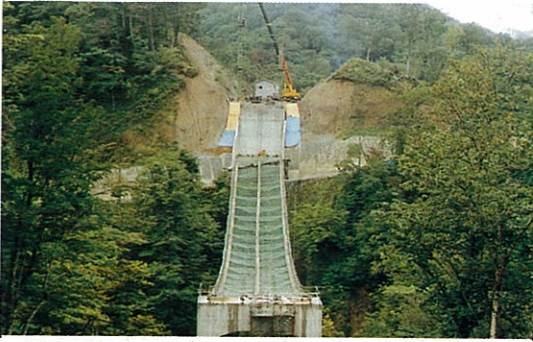
↓ 1) 鉄塔組立、ワイヤーブリッジ設置 (A 2 側)
