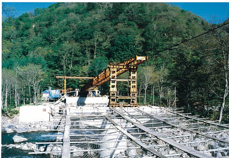
架設桁によるPC桁の架設。
