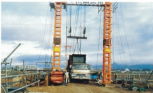
4) トラックからの荷取り状況
