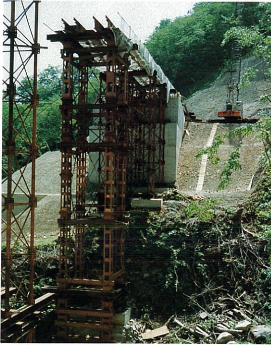
2) ベント設備とレール桁(2)
