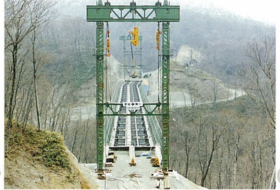
12) 架設完了及び鉄塔
