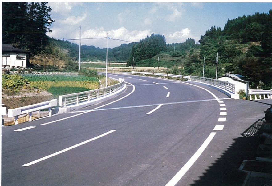
県単独事業で整備された根岸塙線。
