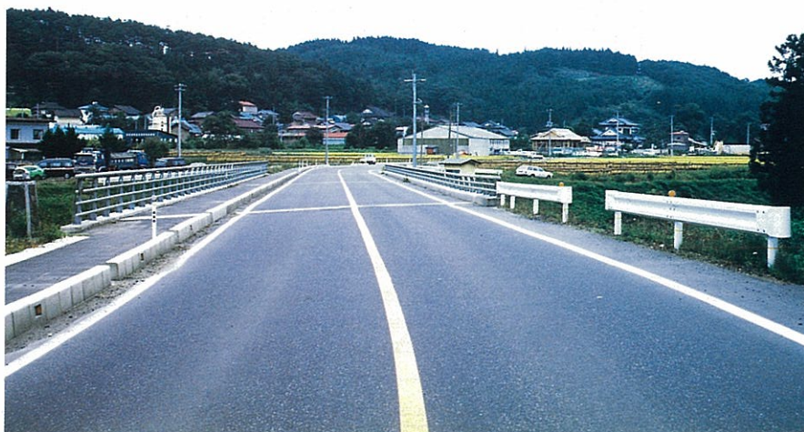
老朽橋が解消され、道路線形も大幅に改善された。
