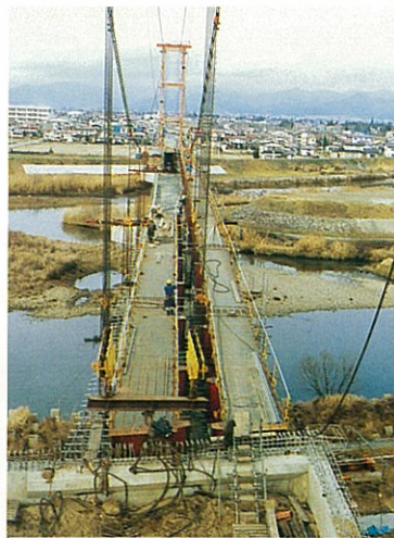
12) G 桁架設状況
