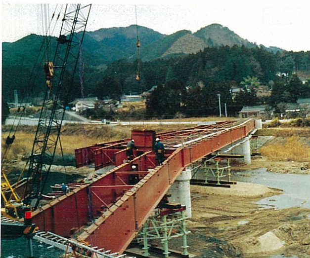
連続折れ桁の架設には細心の注意が払われた。
