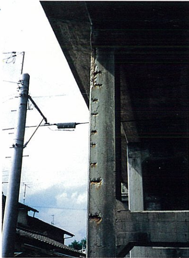
ラーメン橋脚 脚部側面
