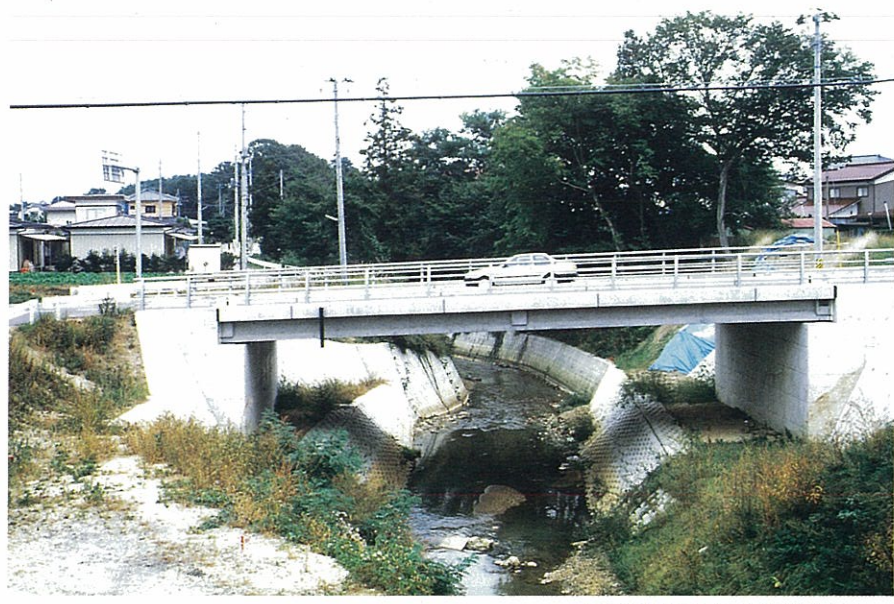
河川の断面不足も解消された。
