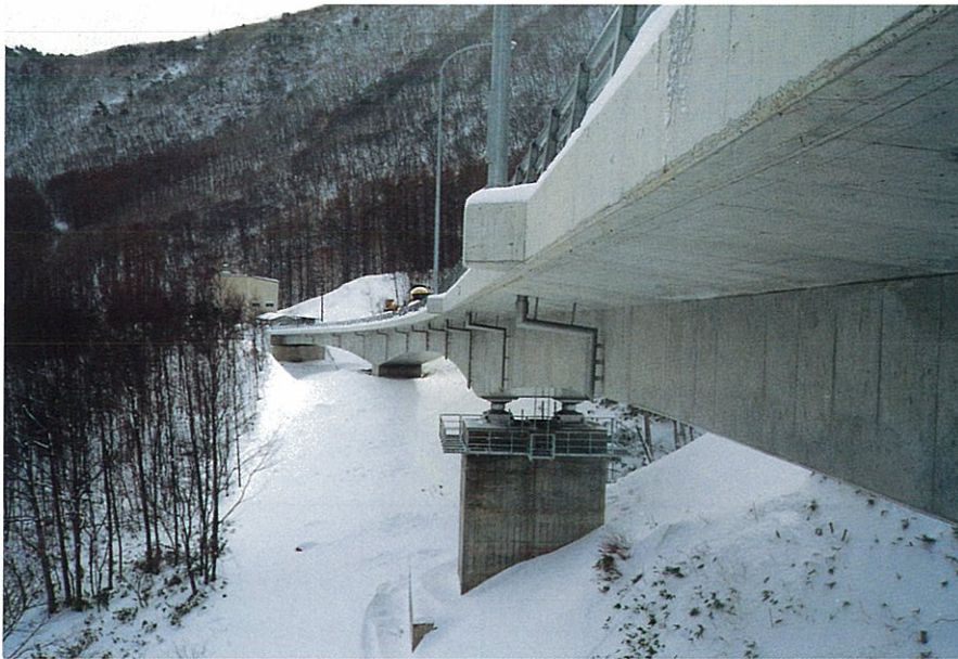
片持式張出工法により施工された変断面の桁は軽快なリズム感にあふれる。
