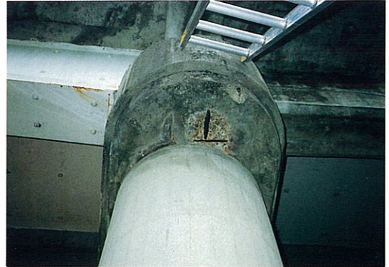
橋脚張り出し部下面
