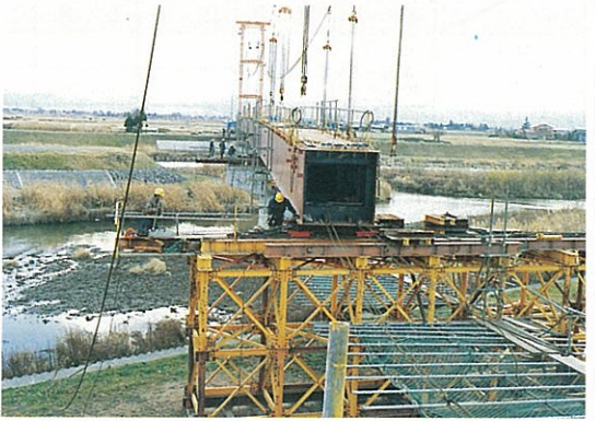
8) 桁所定沓位置への横取り状況
