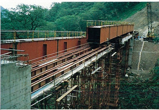
11) G 1 桁送出し状況
