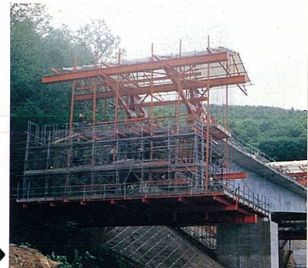
3) 張出し部の施工状況
