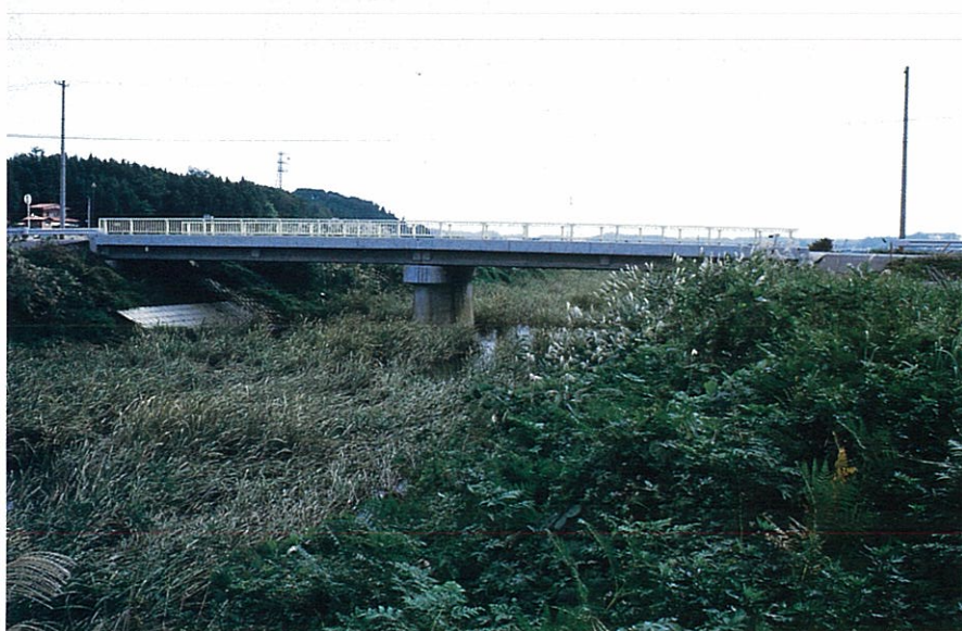
拡幅されたPC桁の側面。
