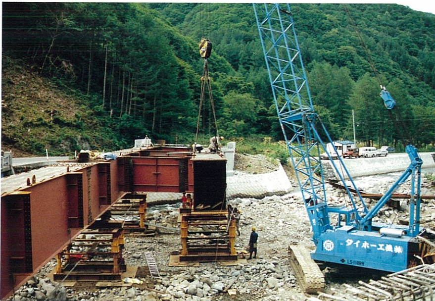
クローラークレーンによる桁架設作業。
