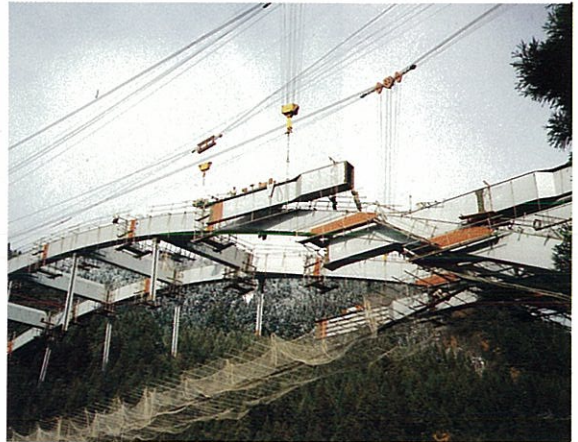
5) 補剛桁の架設(1)
