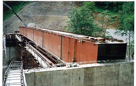
7) G 2 桁送出し完了
