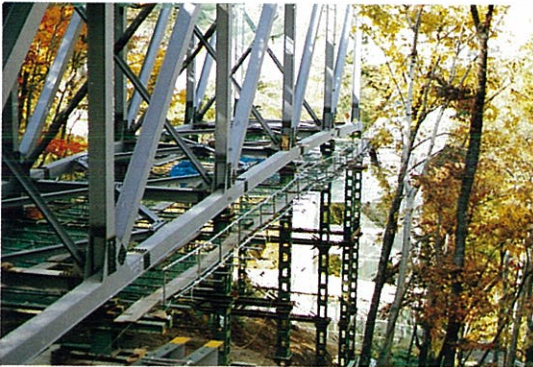
↓ 3) ベント式工法架設状況 (A 1 ～P 1 間)
