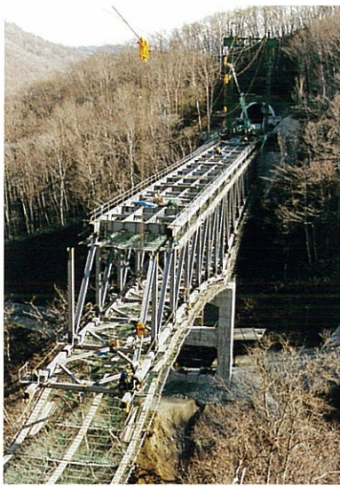
8) 架設状況 (P 1 ~ A 2 間)
