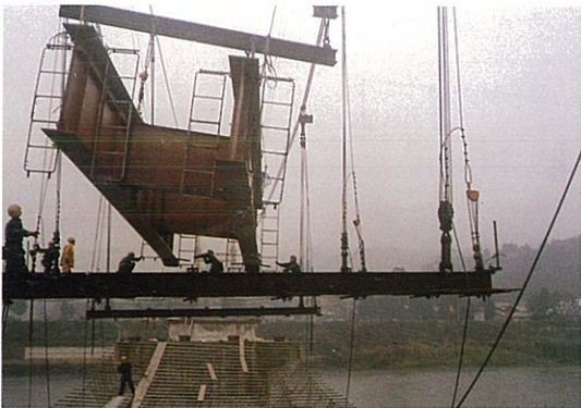
2) 架設状況 (A 1 ~ P 1 間) STEP-1
