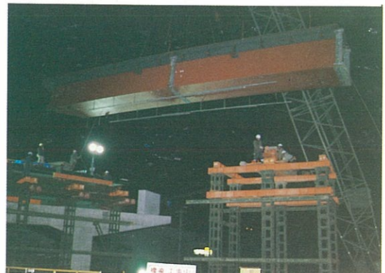
2) G 2 桁架設状況
