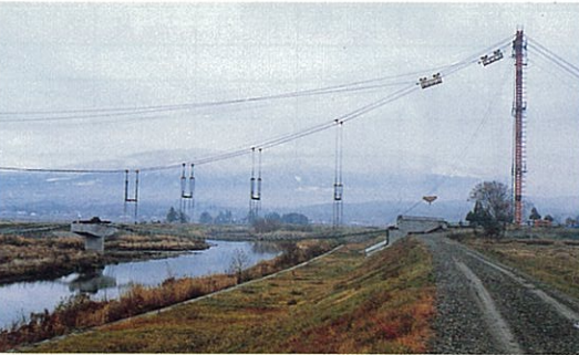
3) ケーブルクレーンと直吊り装置
