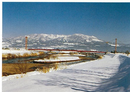
14) 架設完了後越冬期間中
