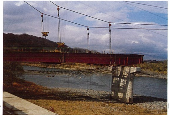
3) 架設状況 (A 1 ~ P 1 間) STEP-1
