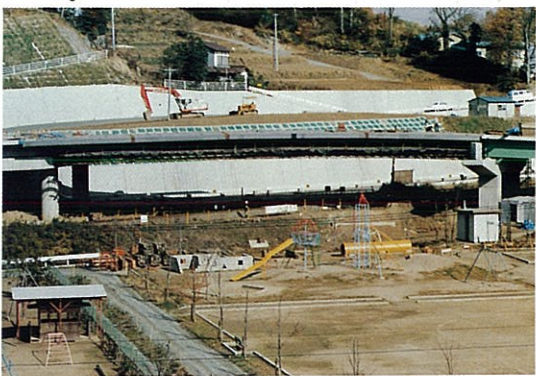
8) 架設完了全景
