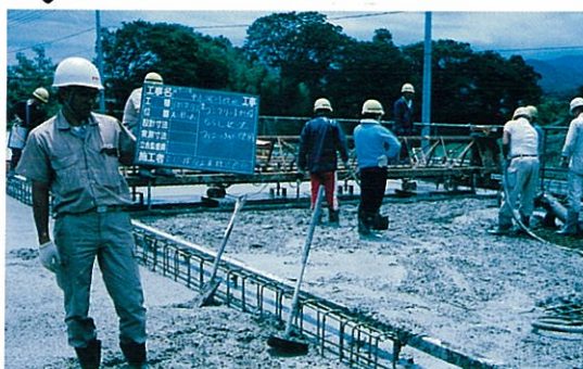
6) コンクリート打設
