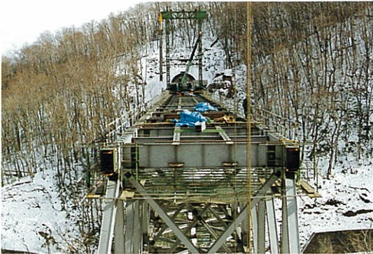
11) 架設状況 (P 1 ~ A 2 間)
