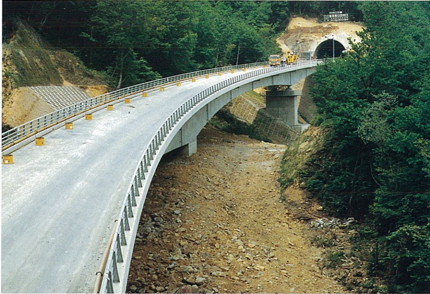
本橋の完成により東鴉川トンネルの工事は大いに促進された。
