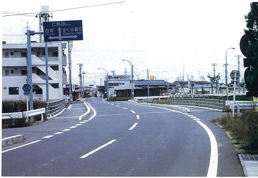
国道4号郡山バイパスのアプローチ部として整備された仁池橋。
