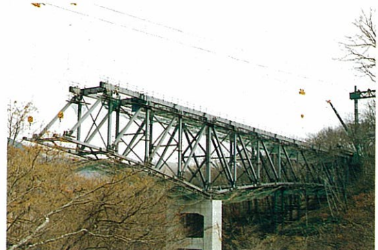
7) 架設状況 (P 1 ～A 2 間)
