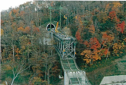
4) 架設状況 (A 1 ～P 1 間)
