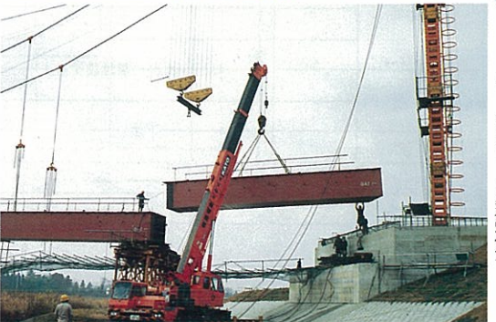
9) A 1 側端のトラッククレーン架設状況
