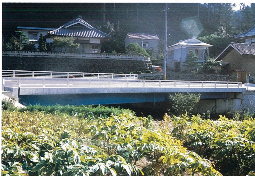
改良関連橋りょうとして完成した出戸橋。
