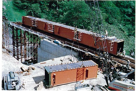
5) G 2 桁送出し + 桁組立
