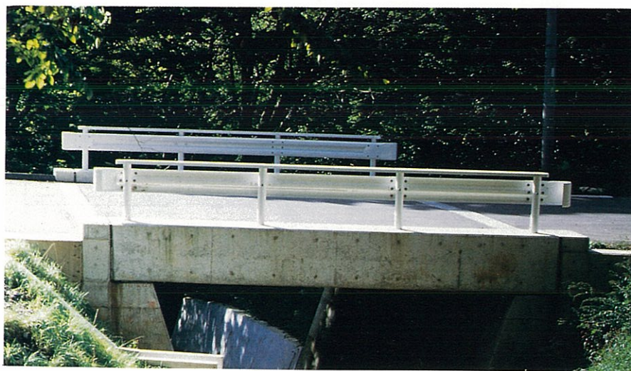
RC床版が拡幅され十分な幅員が確保された。
