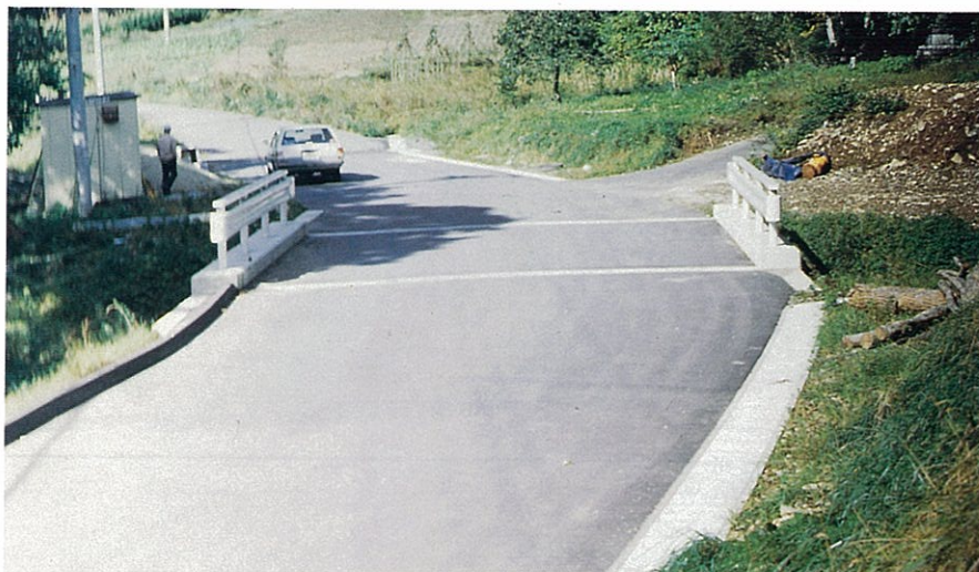
RC床版が拡幅され十分な幅員が確保された。
