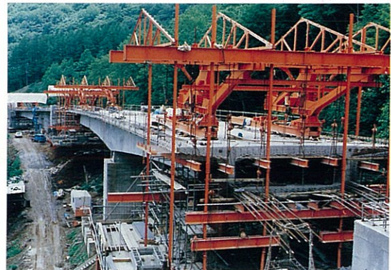
5) 張出し部の施工状況
