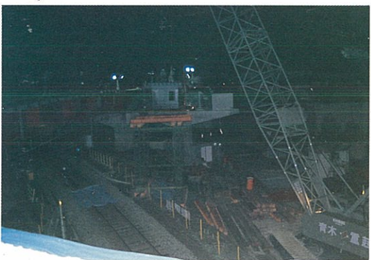
5) G 1 桁架設状況(その1)
