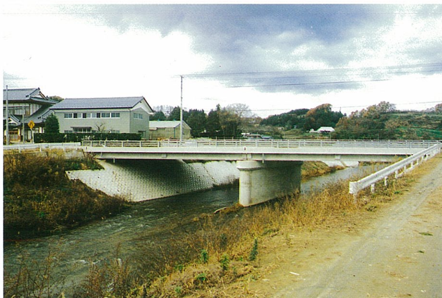
小規模河川改良と合わせ、整備された新橋。
