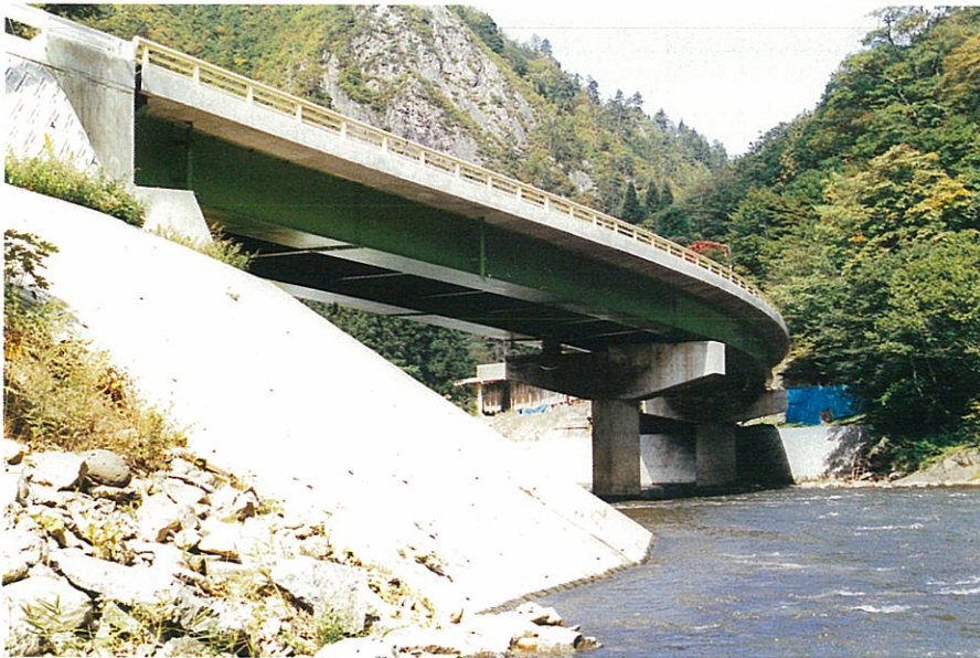
鋼箱桁が美しい曲線を描いている。
