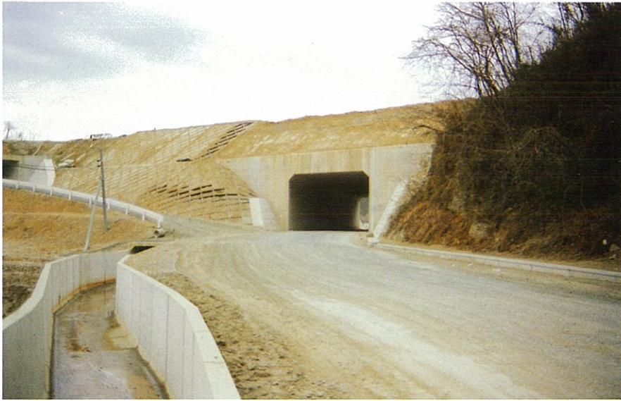
市道を跨ぐ大規模なBoxカルバート。改良事業として昭和59年度工事に着手。
