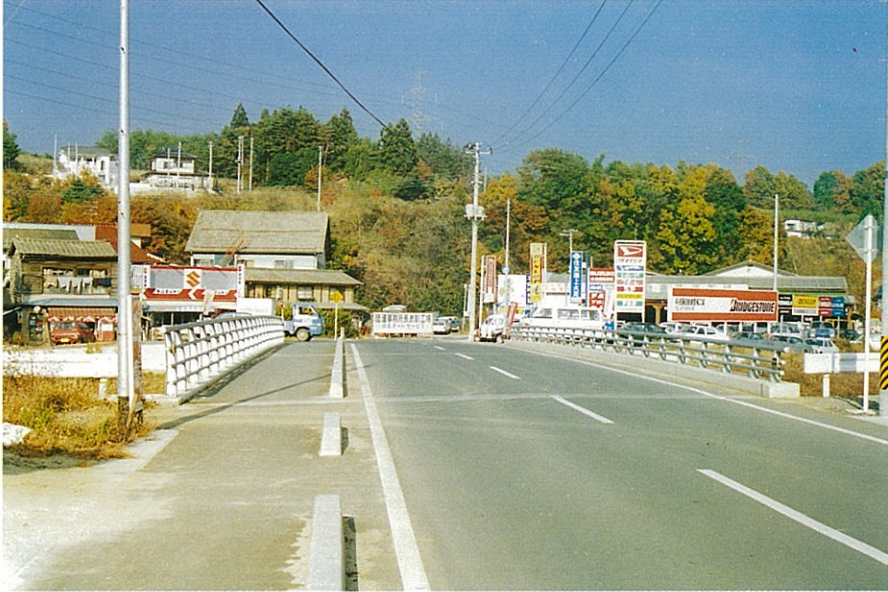
橋の架替えにより、整備された主要地方道川俣安達線。
