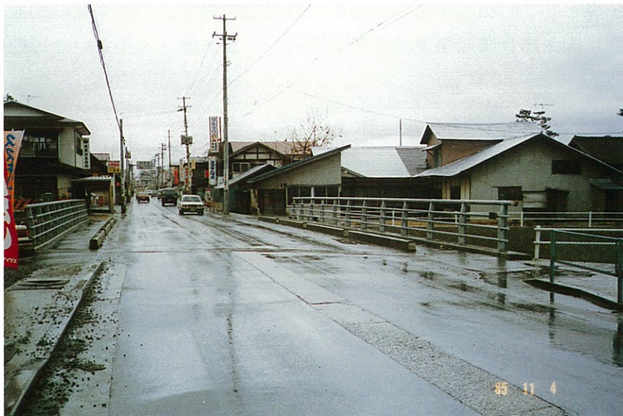
両側歩道がつき、幅員の広くなった馬橋。
