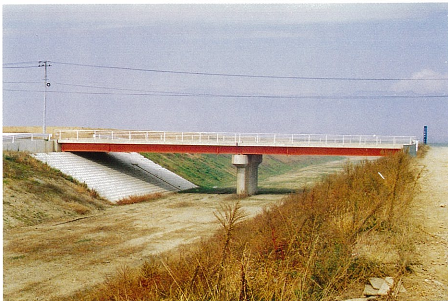
東根川の小規模河川改良と合併し架けられた新橋。
