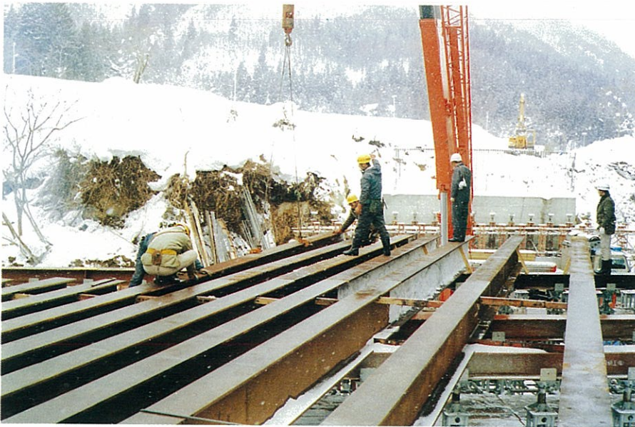
冬期間施工となった上部工施工状況（オールステージング工法）。
