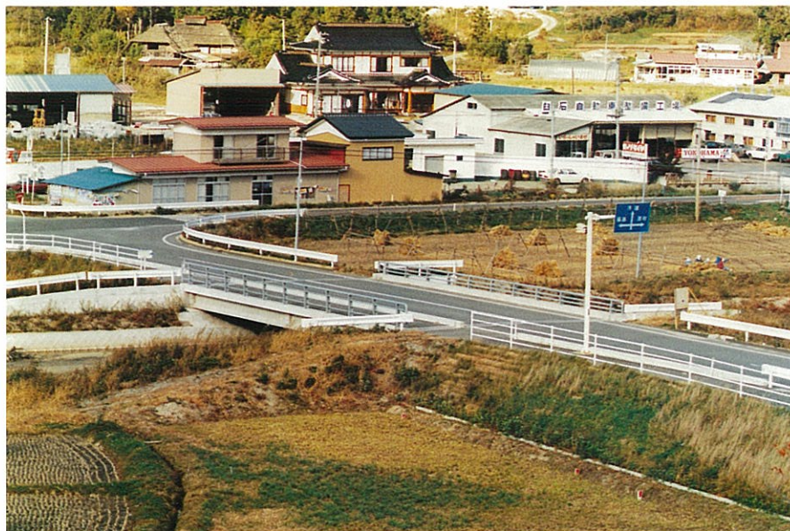
交差点改良を含め、架替えられた飯樋橋の全景。
