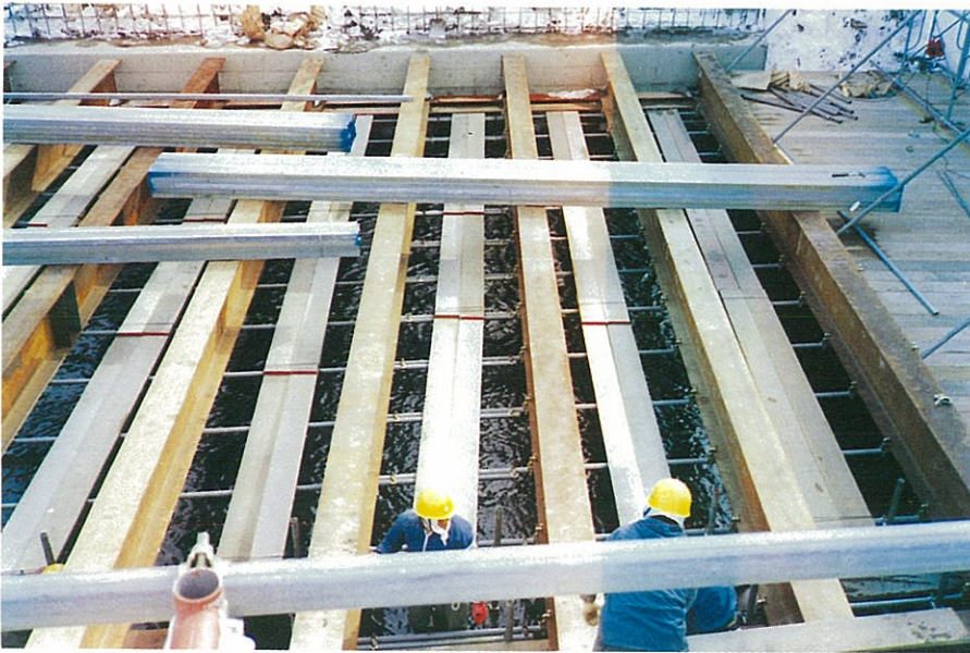
オールステーシング工法における支保工施工状況。
