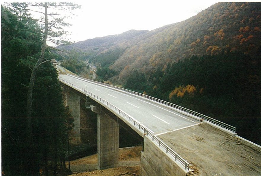
山岳道路特有の厳しい地形条件のところに基礎が建っている。
