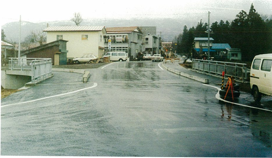
極端なバチ型構造を有する高橋橋。
