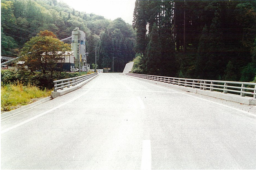
小綱木橋とともに新しく生まれ変わった国道400号。
