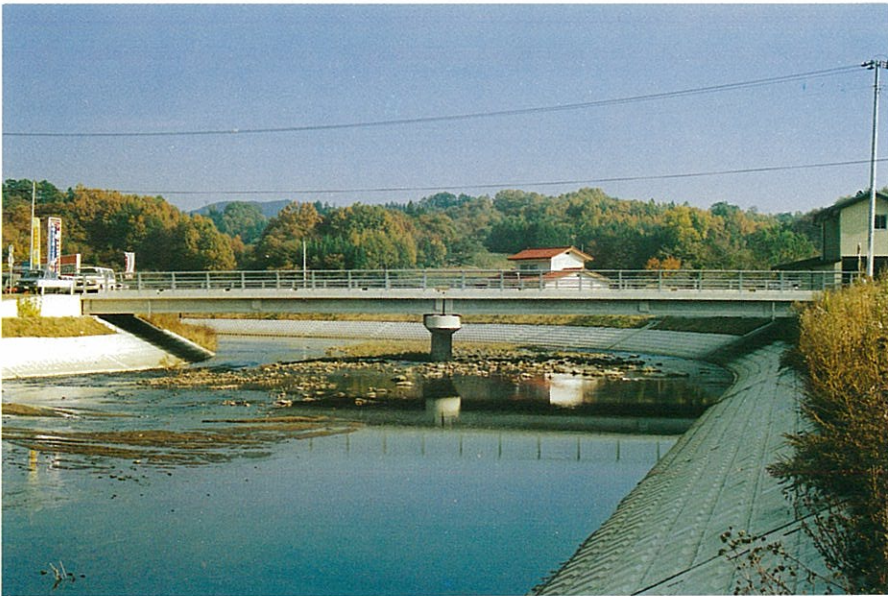
小規模河川改良と合せ、新しくなった下田橋。
