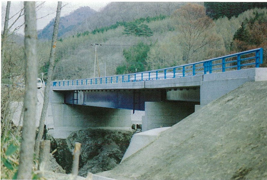
館岩川の流心を避け異スパンで架けられた新橋。生徒も安心して渡れる通学路でもある。
