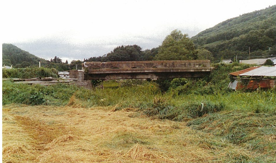
国道とは名ばかりの旧橋。整備の遅れている国道399号。
