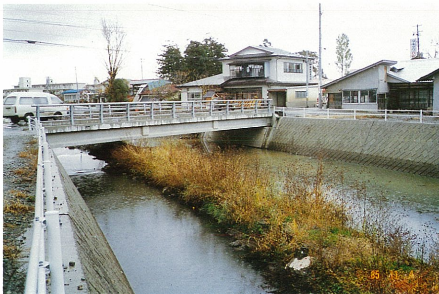
合併施工により整備された新橋附近。
