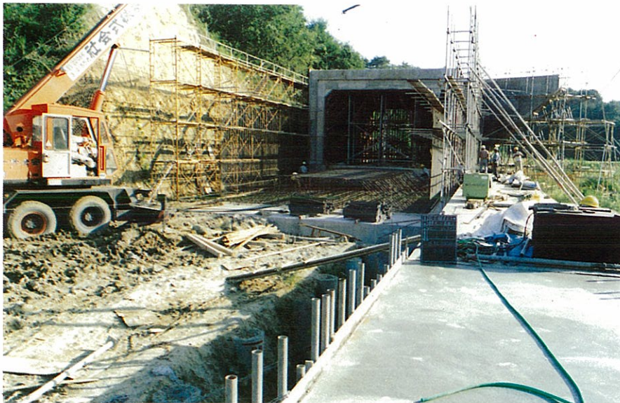
RC杭を施工後、射体を打上げていく現場
