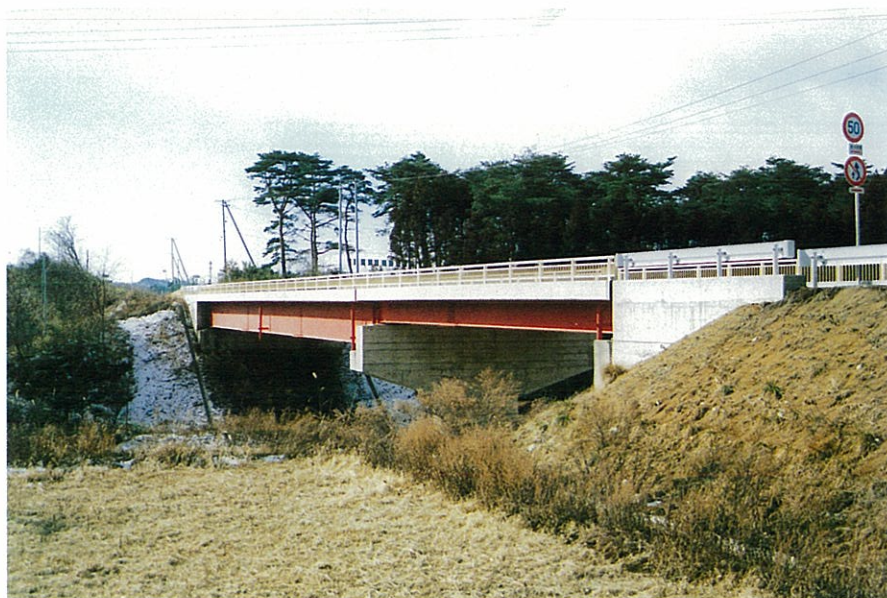
鈹桁とH鋼桁を組合せ、近接橋としてスパン割りされた新橋。
