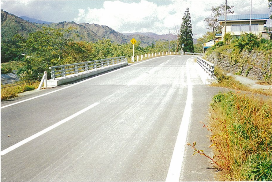
「ヘキサロック工法」により連続舗装となっている。
