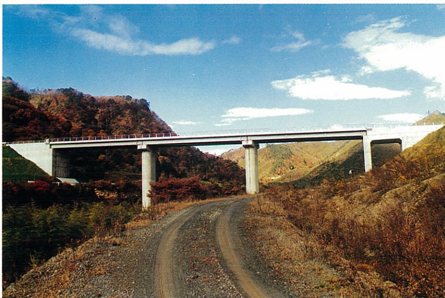
3径間の標準的のスパン割りを有する新橋。
