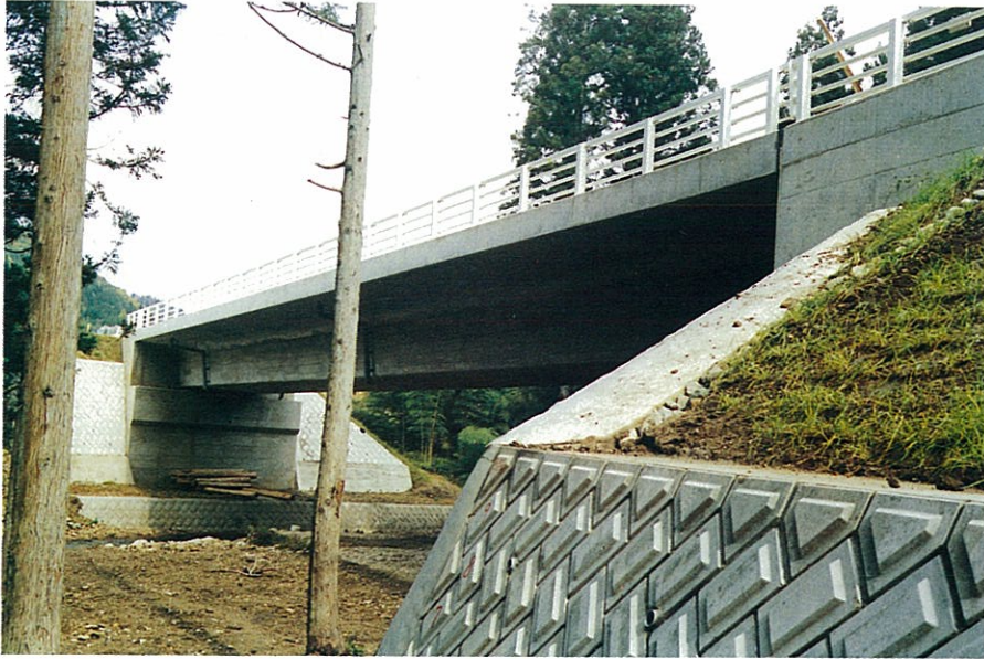
コンクリート1 B Q Xの端整な美が際立つ落合橋。
