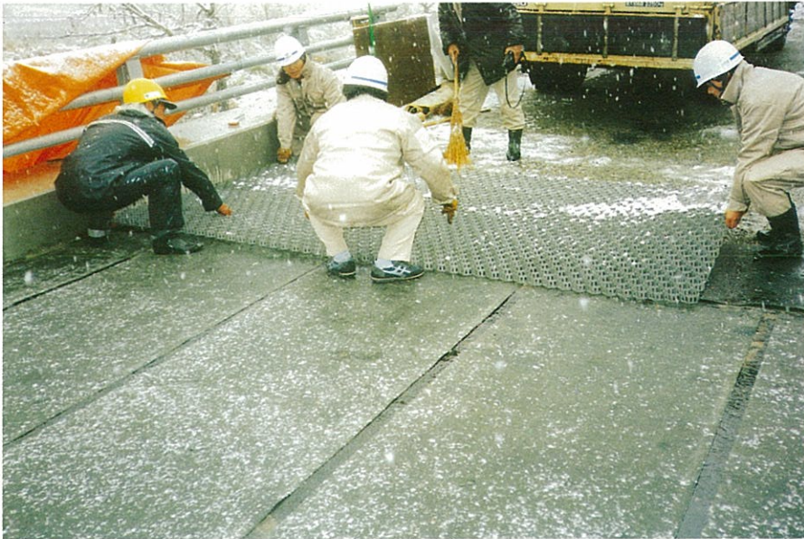
スライディングシート (Asシート) の上に、ヘキサパネルを敷設。
