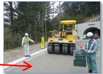
路盤(碎石)を強固に締め固めています。
