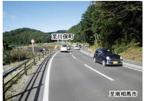
県道原町川俣線芦原工区(飯舘村) 平成28年10月25日開通
