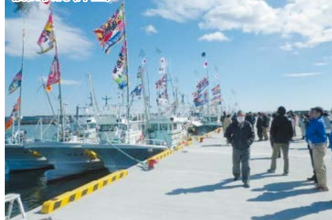
復旧状況(岸壁)
