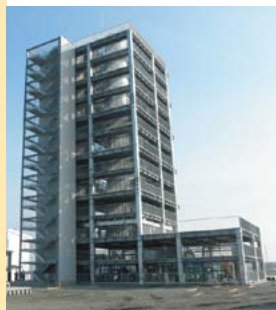
試験用プラント 平成31年2月開所
