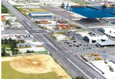
臨港道路の整備 (4車線化)
