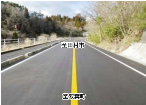
国道288号野上山神工区(大熊町) 平成28年3月29日開通
