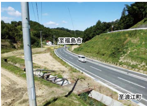
国道114号小網木バイパス(川俣町) 平成27年6月28日開通
