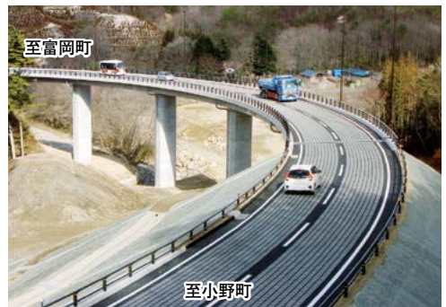
県道小野富岡線吉間田工区(いわき市) 平成27年3月24日開通
