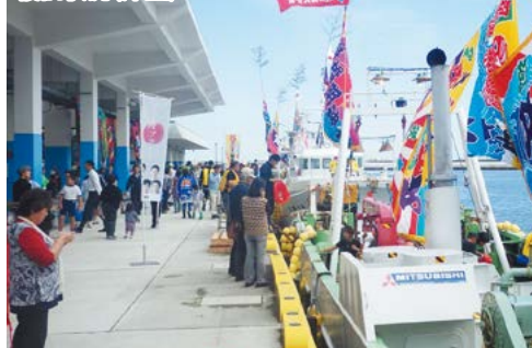
復旧状況(岸壁)
