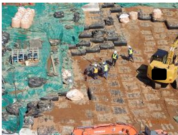
下流側埋立地の埋立状況の確認
