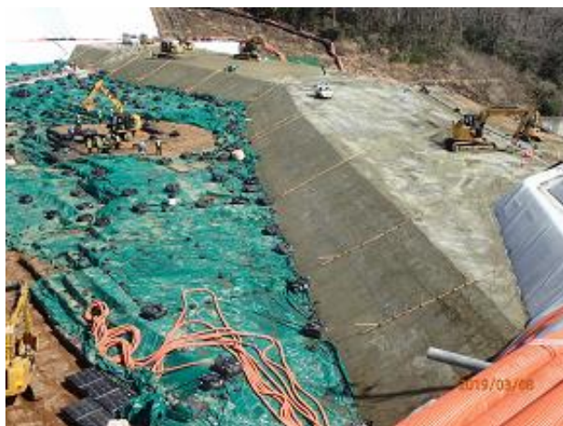
土堰堤の築堤状況の確認
