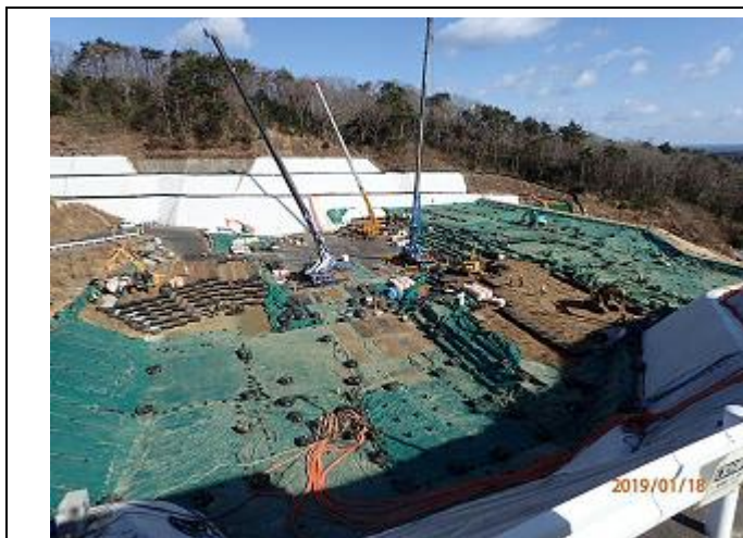
下流側埋立地の埋立状況の確認
