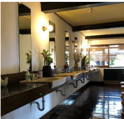
既存洗面台・照明／トイレ前洗面台
