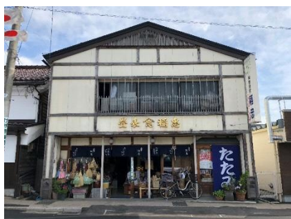
既存正面外壁、付柱・縦格子／外観
