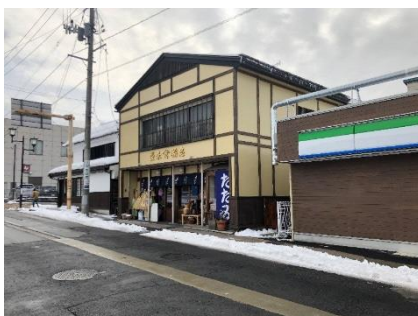
新規側面外壁、看板撤去／外観
