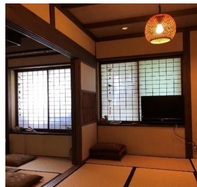
既存障子／広間
