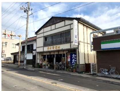
既存側面外壁、既存看板／外観
