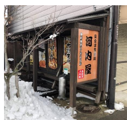
新規屋根、看板／外構
