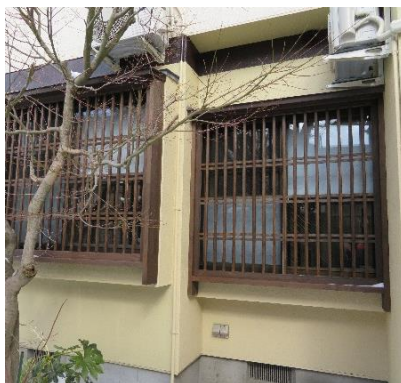
新規格子、貯水槽撤去、植栽一部剪定 ／建物西側
