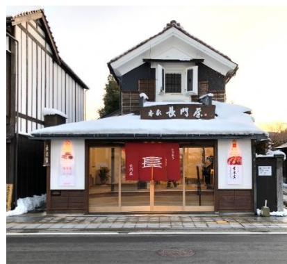
新設外観、木製建具／エントランス
